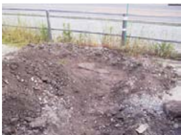
3-② 二ノ丸トイレ雨水排水管設置 礎石検出状況
