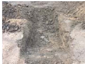
32-① 本丸南東部松樹移植工事 小学校水道管
