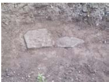
3-③ 二ノ丸トイレ雨水排水管設置 礎石近景
