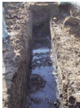
18-① 本丸西堀内見学テラス設置 掘削完了状況
