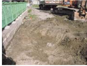
6-① 二ノ丸駐車場旧便所跡地路盤工 工事立会状況
