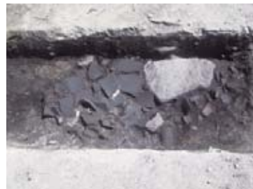
4-1-③ 二ノ丸駐車場路盤工・ 電線埋設溝設置 礎石検出状況
