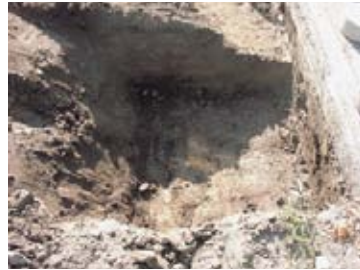
7-① 二ノ丸駐車場信号柱設置 整地層確認状況
