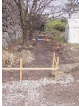
17-① 本丸天守台周辺排水路設置 東面掘削状況
