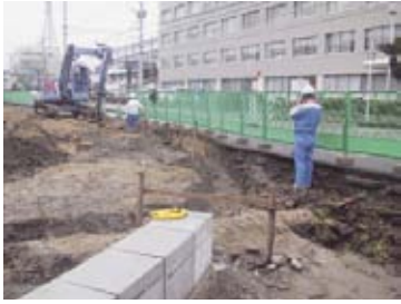
15-① 二ノ丸駐車場北側排水路改修 工事立会状況
