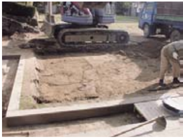
21-① 鯨の門東路盤工 工事立会状況
