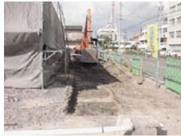
8-① 二ノ丸駐車場路盤工 工事立会状況
