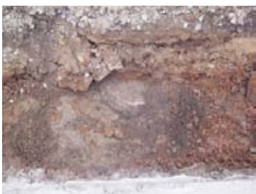
16-③ 二ノ丸駐車場北側排水路改修 礎石検出状況
