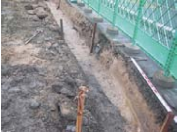
15-② 二ノ丸駐車場北側排水路改修 砂整地層検出状況
