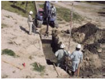
9-① 本丸南西隅櫓台 内側排水路 工事立会状況
