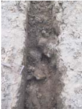
2-② 二ノ丸トイレ下水道・電気管設置 集石検出状況
