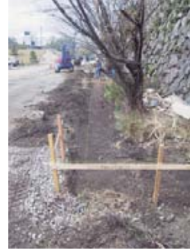
17-② 本丸天守台周辺排水路設置 南面掘削状況
