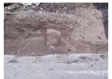
14-③ 二ノ丸駐車場南側排水路改修 赤石立石検出状況
