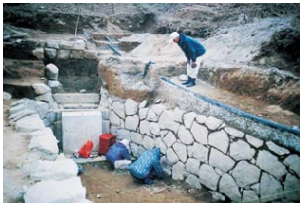
1 小寺川井樋石垣下トレンチ調査状況
