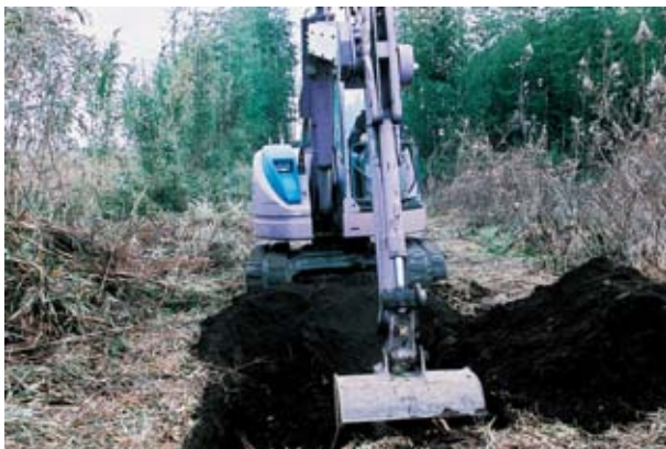
3 八子二本黒木遺跡調査状況
