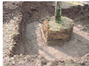
25-② 鯨の門東花壇・樹木撤去工 掘削完了
