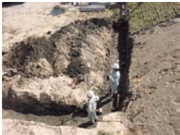
9-② 本丸南西隅櫓台 内側排水路 掘削完了状況
