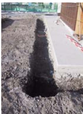
22-② 二ノ丸駐車場トイレ周辺雨水排水路設置 掘削状況（西側）
