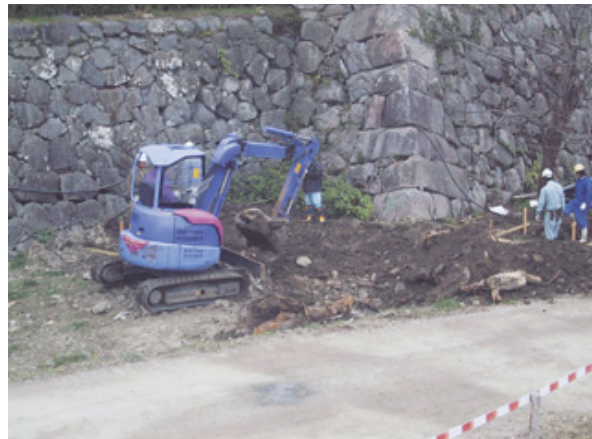
17-③ 本丸天守台周辺排水路設置 工事立会状況
