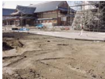
30-① 鯨の門東舗装工 掘削状況（北東から）
