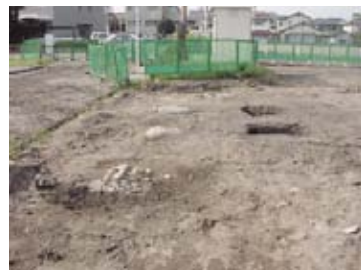
4-2-① 二ノ丸駐車場路盤工・ 電線埋設溝設置 礎石検出状況
