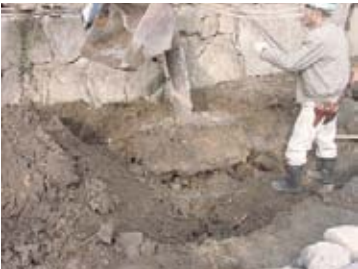
27-① 御式台北側桜樹移植 施工状況
