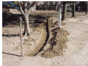
31-① 鯨の門電線埋設工 掘削完了（西から）
