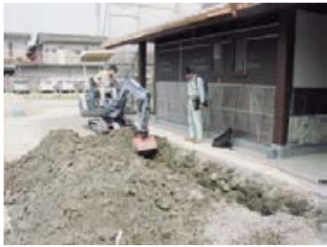
2-① 二ノ丸トイレ下水道・電気管設置 工事立会状況
