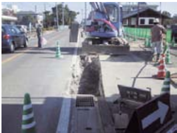
16-① 二ノ丸駐車場北側排水路改修 工事立会状況
