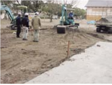
26-① 鯨の門東路盤工御玄関前 石貼基礎工 掘削状況
