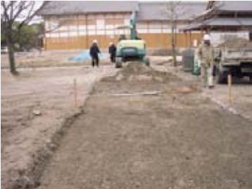
26-② 鯨の門東路盤工御玄関前 石貼基礎工 掘削完了
