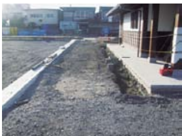
22-① 二ノ丸駐車場トイレ周辺 雨水排水路設置 掘削状況（南側）
