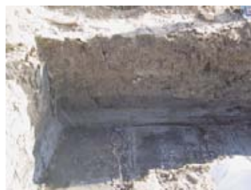
18-② 本丸西堀内見学テラス設置 掘削完了状況
