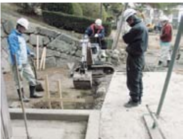
29-① 鯨の門東側排水路 掘削状況
