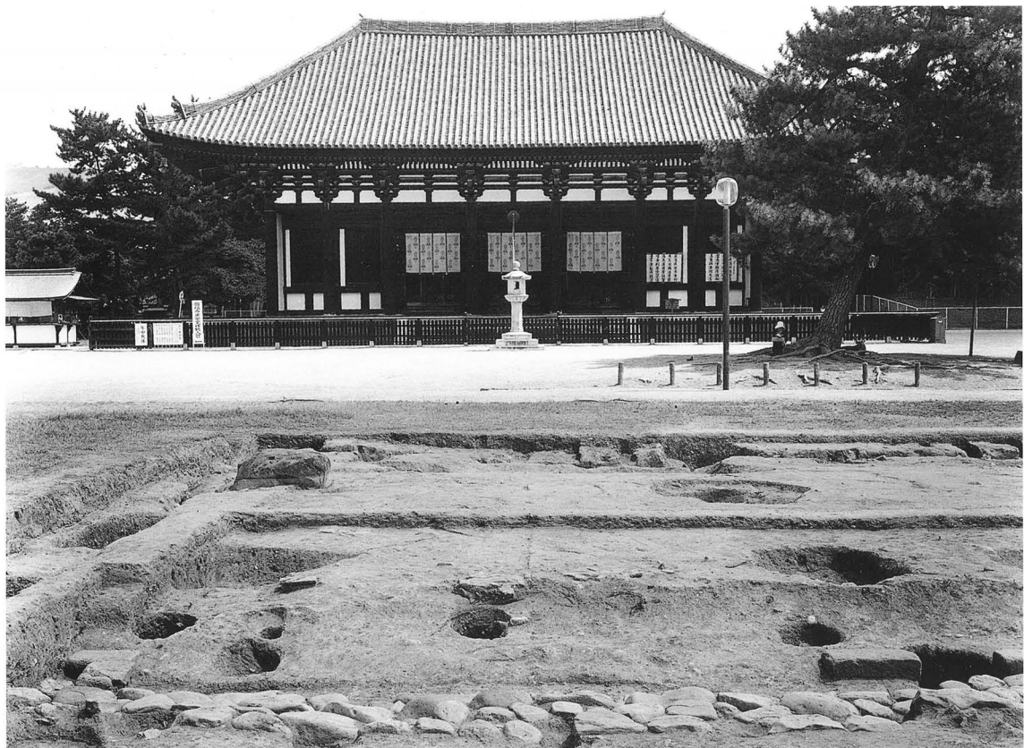
第20図 階段と東金堂（西から）
