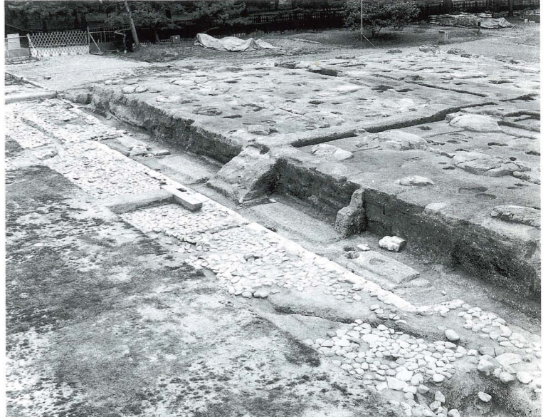
第27図 南面階段 (南東より)
