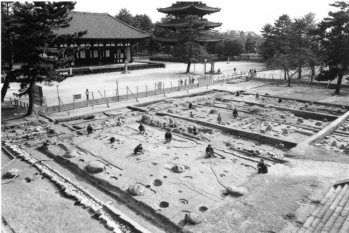
第4図 回廊部分全景（北西から）
