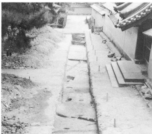
第16図 第273トレンチ全景(北から)
