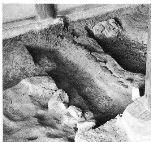
4. 推定北室の西雨落溝
