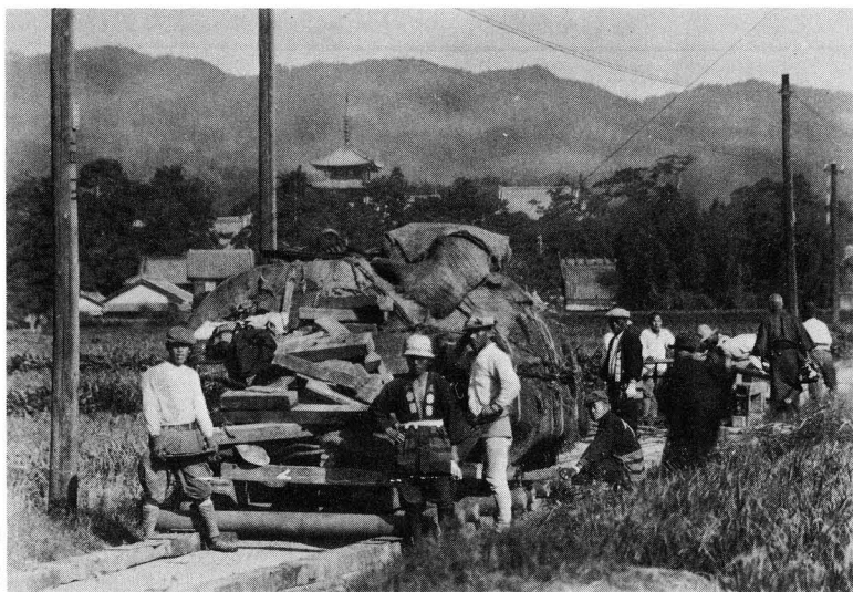
第94図 礎石の運搬状況 (昭和14年10月撮影)
