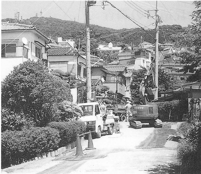
A 地区調査地遠景
