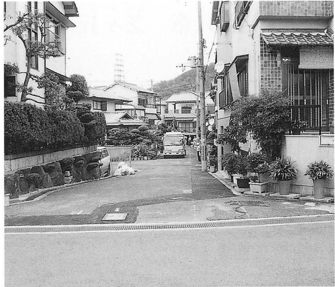
A 地区調査地遠景
