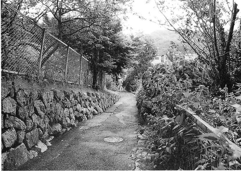
A 地区調査地遠景
