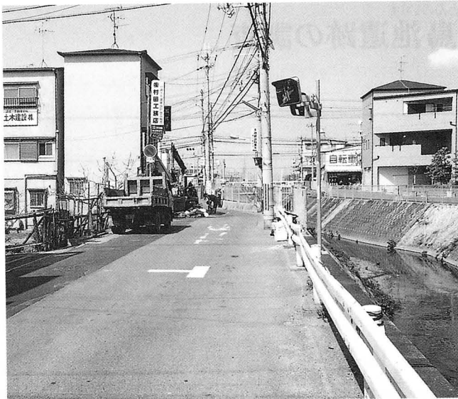
A地区調査地遠景
