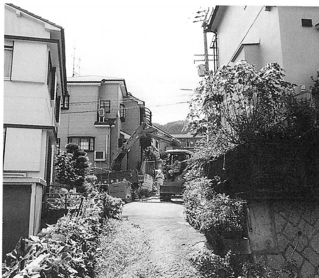
A地区調査地遠景
