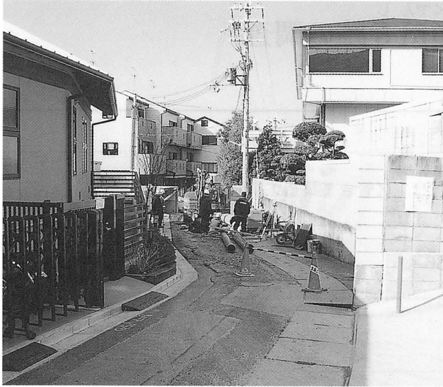
A地区調査地遠景
