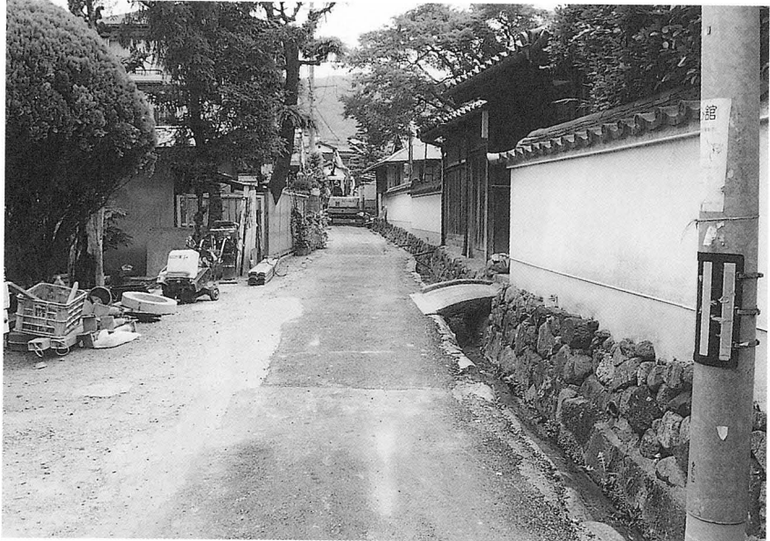
A 地区調査地遠景
