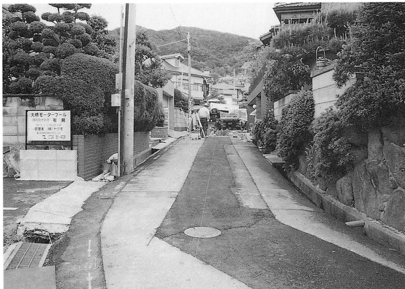
A地区調査地遠景
