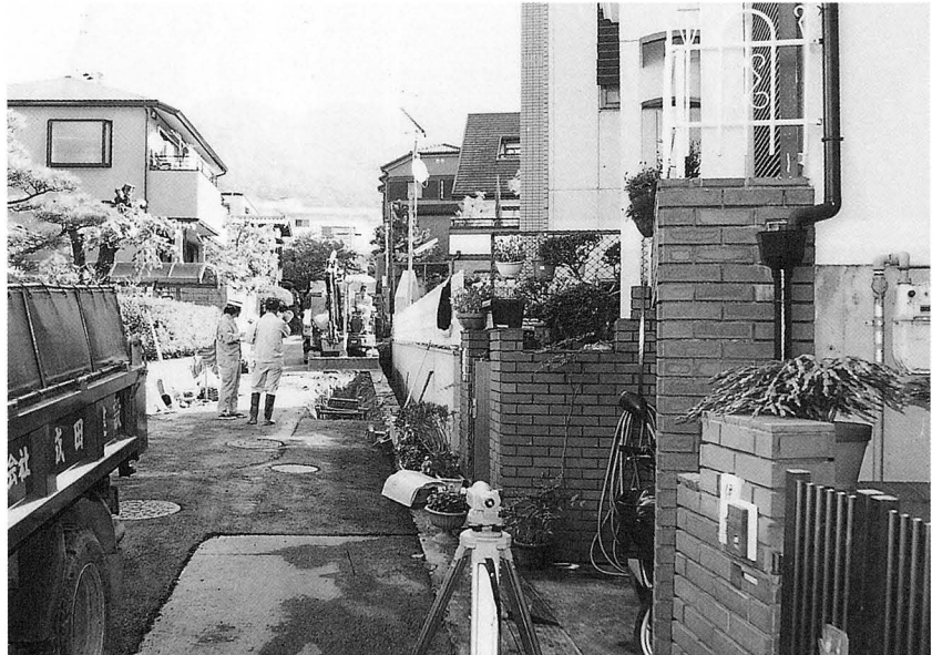
A地区調査地遠景
