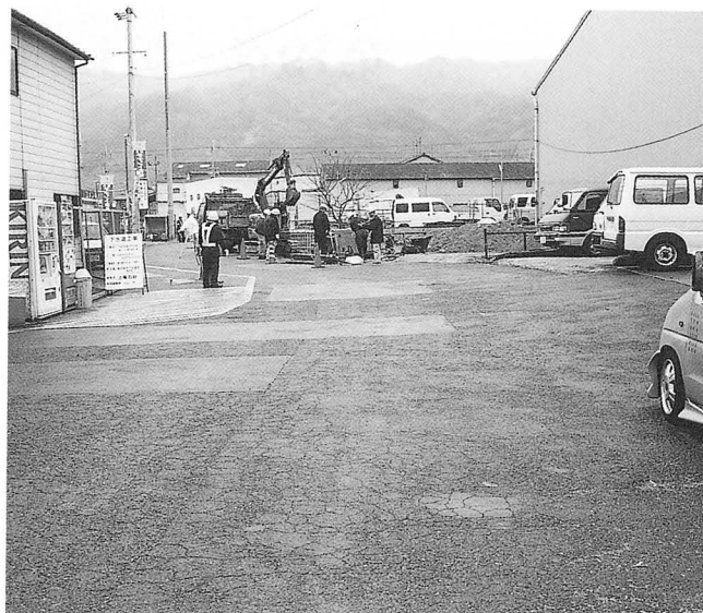
A地区調査地遠景
