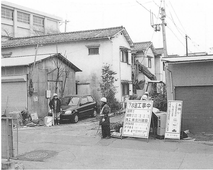
A地区調査地遠景
