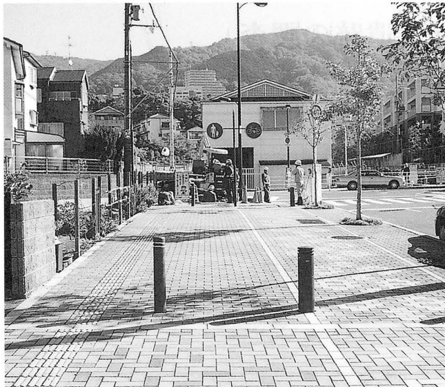
A地区調査地遠景
