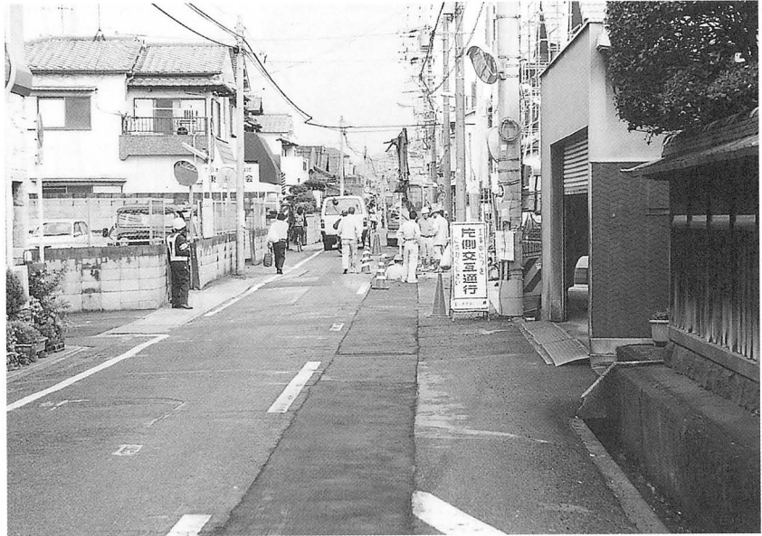
B地区調査地遠景
