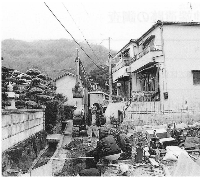
A-2 地区調査地状況
