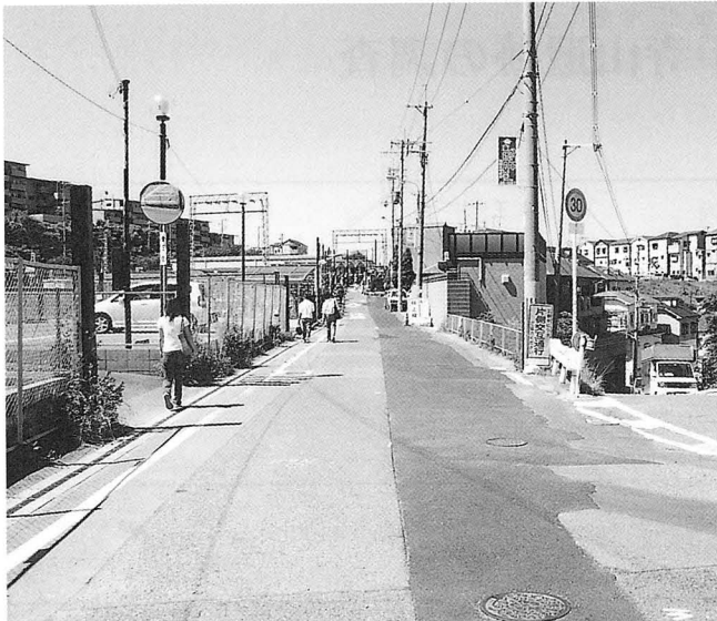
A地区調査地遠景
