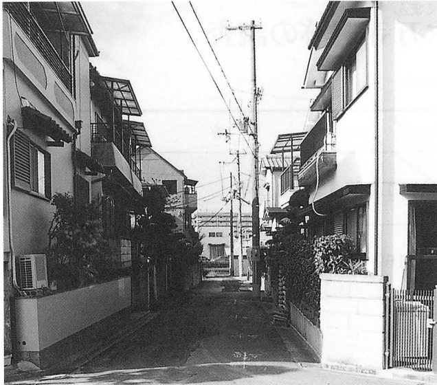
A 地区調査地遠景
