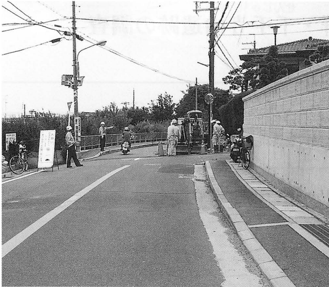
A地区調査地遠景
