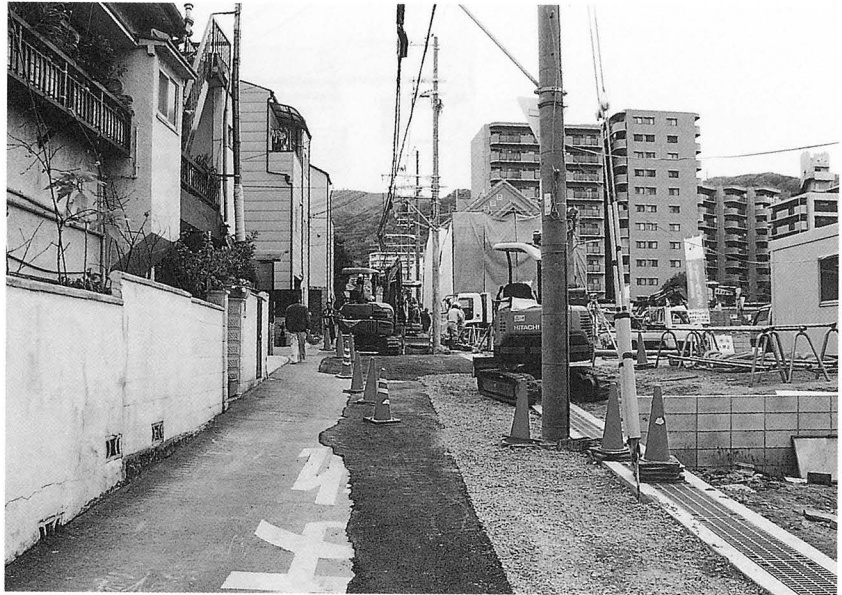
A地区調査地遠景
