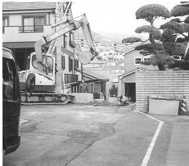
A地区調査地遠景
