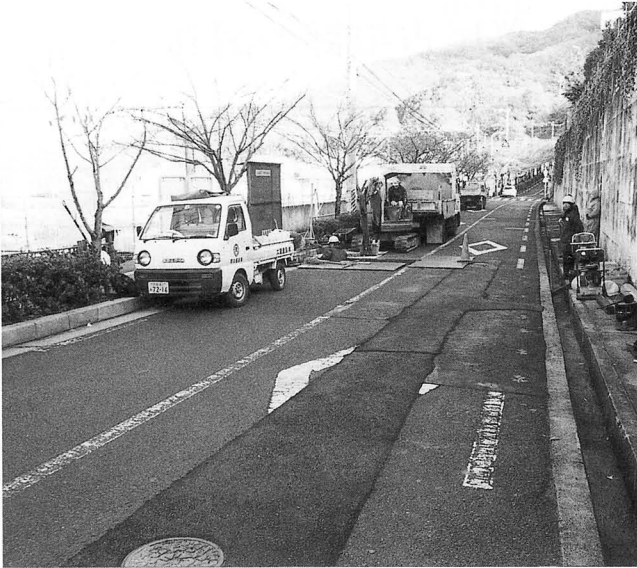
A 地区調査地遠景
