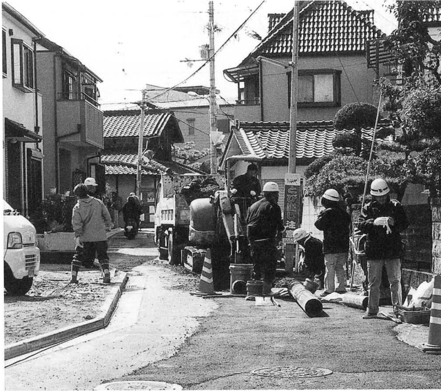
A 地区調査地遠景
