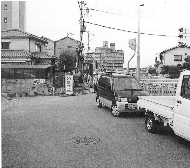
A 地区調査地遠景
