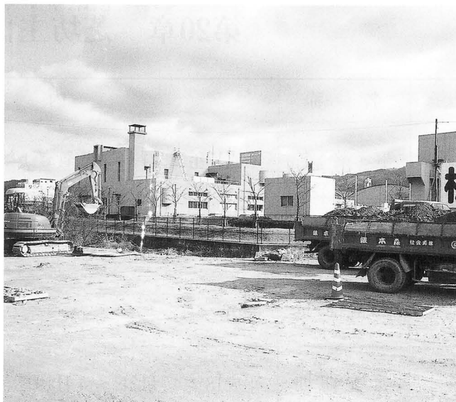
A地区調査地遠景
