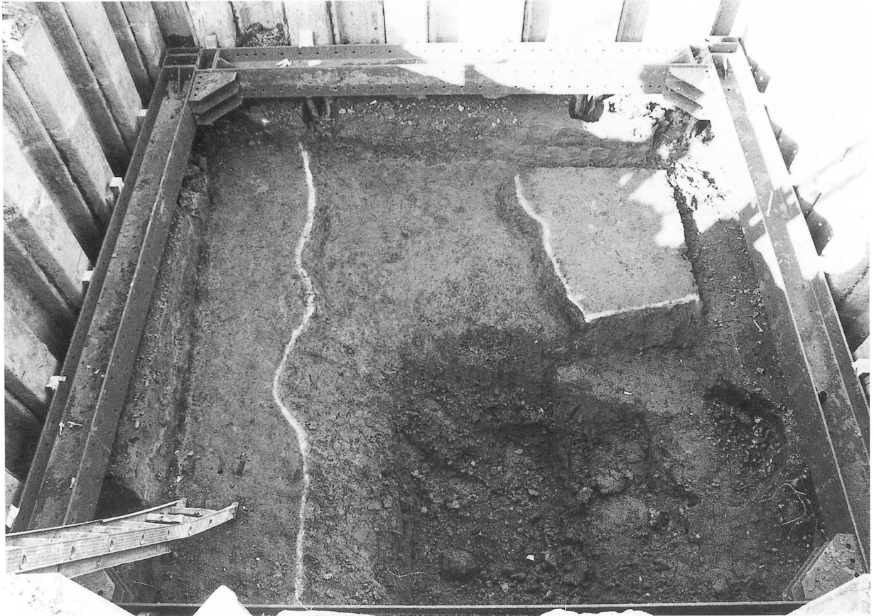
第3層上面溝完掘状況（東より）
