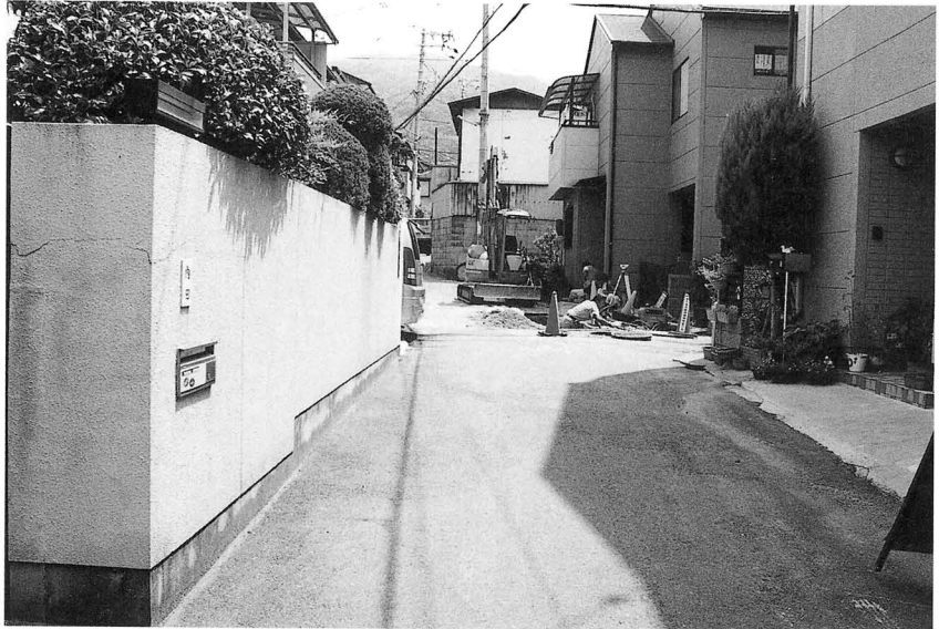
A 地区調査地遠景
