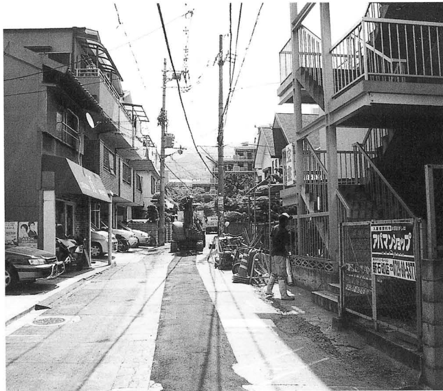
A 地区調査地遠景
