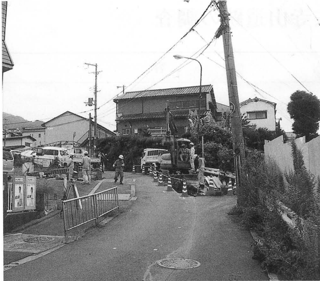
A地区調査地遠景
