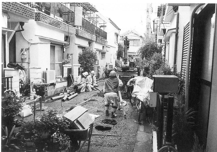
A地区調査地遠景
