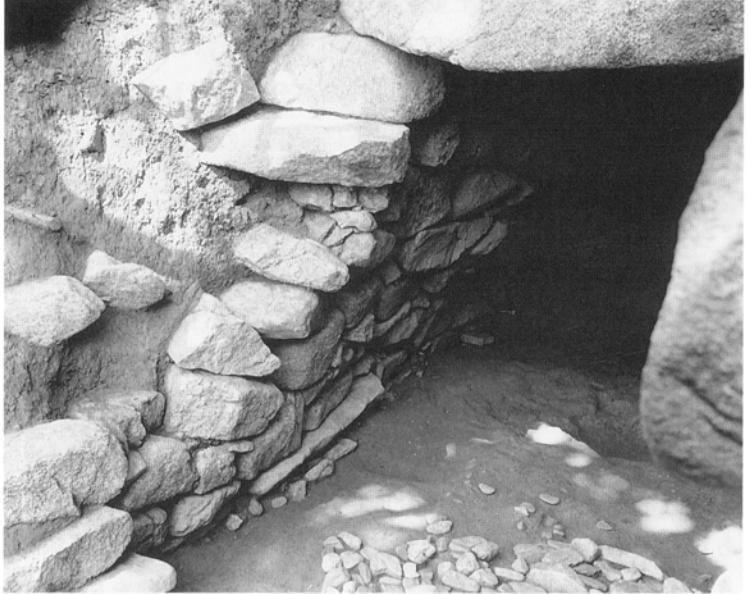
図57 石室左側壁（開口部から）
