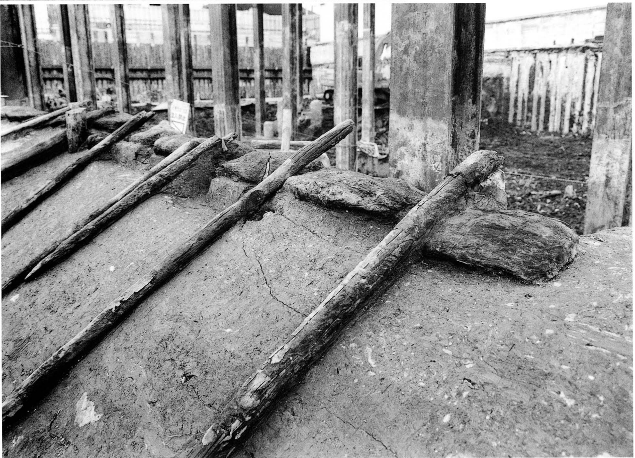
土塁東面の内部構造（竹しがらみ除去後：北東から）
