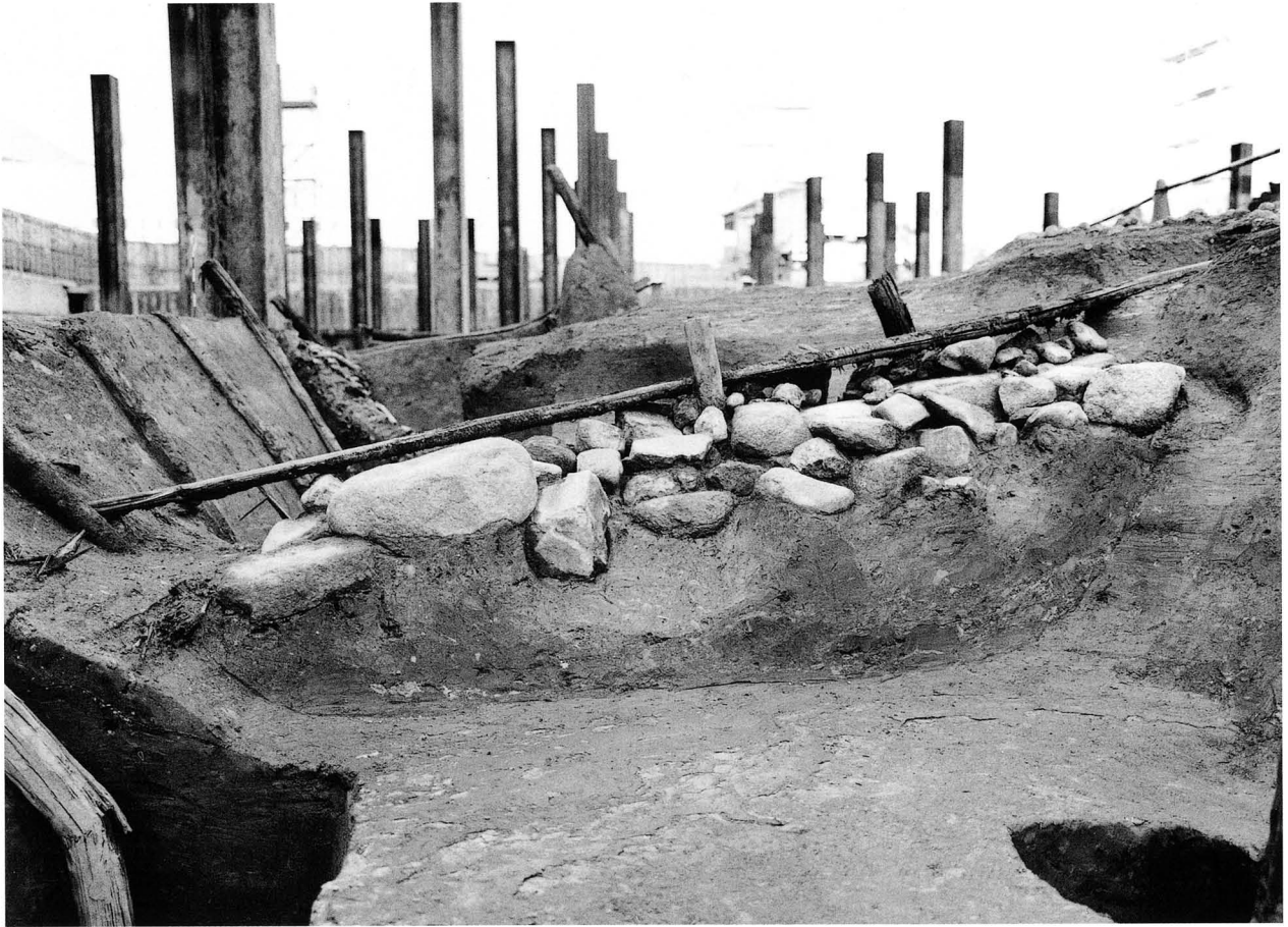
暗渠排水管（南から）
