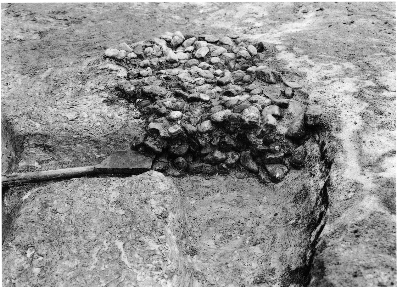
暗渠排水管 集水施設（南から）
