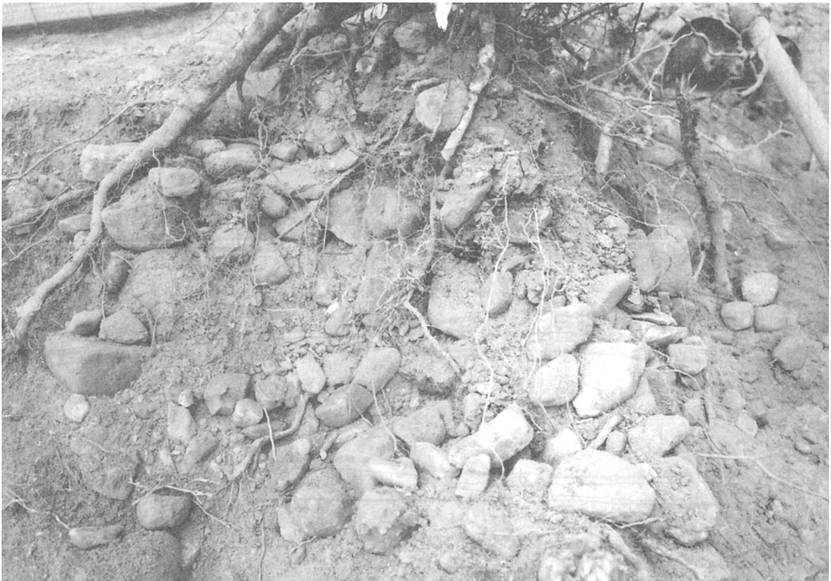
写真3 積み石の状況
