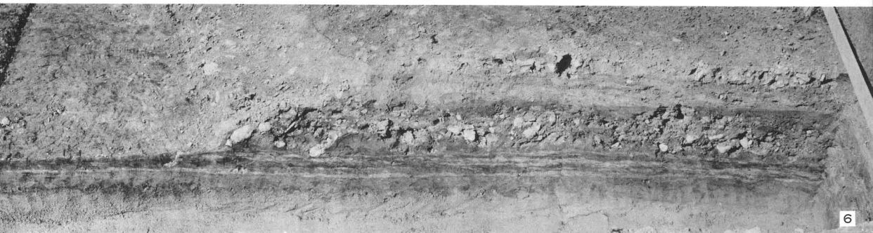
1 羅城門基壇 (西から) 2 同左 3 同左 (南から) 4 羅城門基壇断面 5 羅城門基壇 (南から) 6 羅城門基壇版築 (南から)
