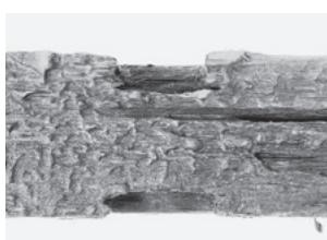
図268 上段土居桁（西側）の欠込部分
