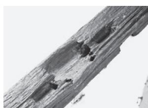
図266 上段土居桁（西側）の間柱部分の仕口
