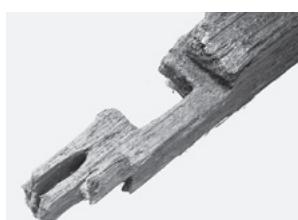
図265 上段土居桁（西側）の相欠と継手
