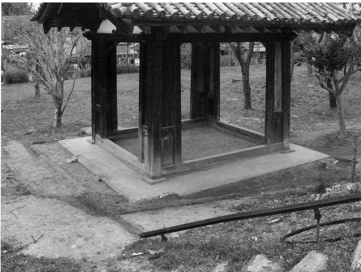
復旧後基壇(北東から)
