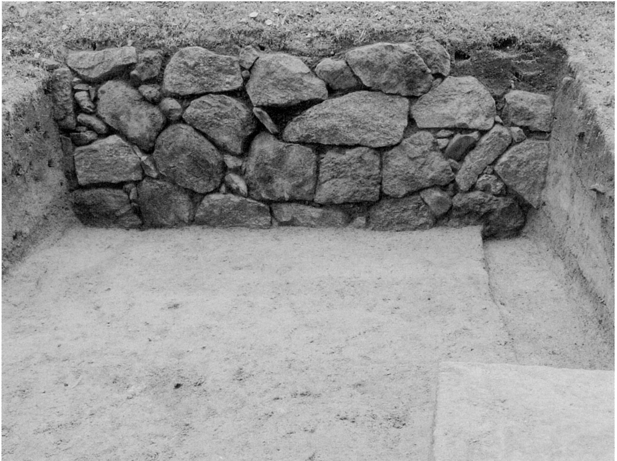
第1調査区 石垣(南から)
