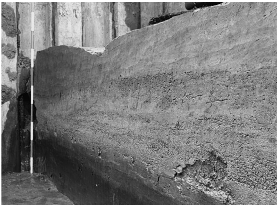
西壁断面細部(北東から)
