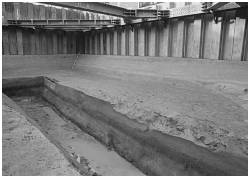
北壁中央部以西全景 (南東から)
