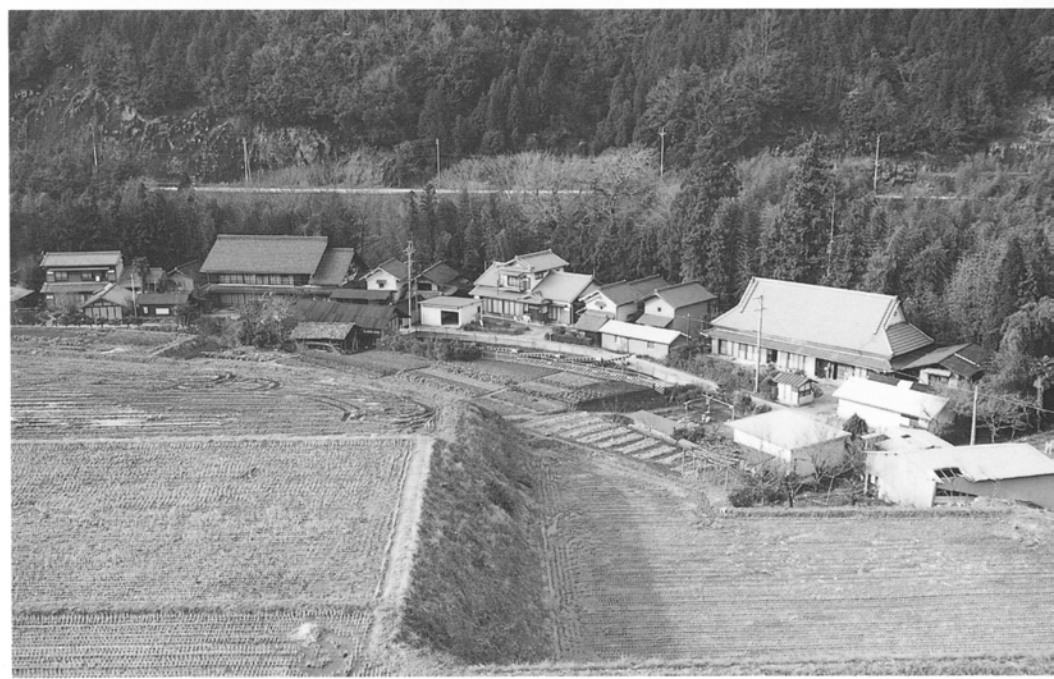
② 91調査区 近景 (南東より)
