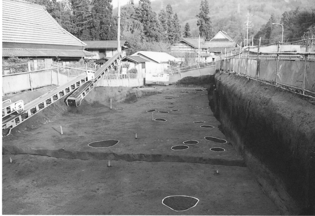
① 91調査区東側 完掘状況 (西より)
