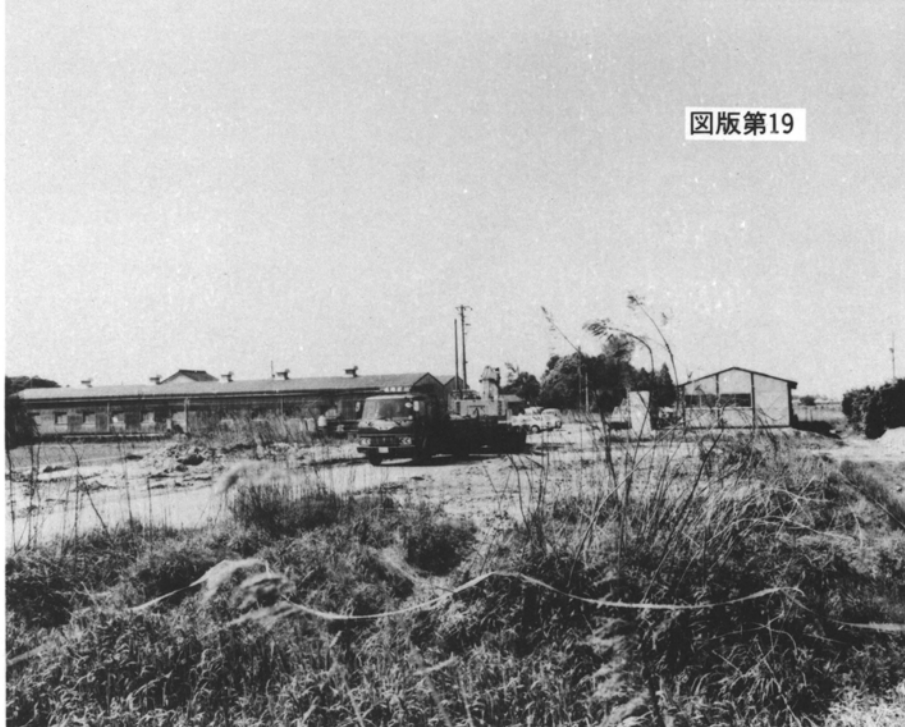
C区 表土掘削 (北より)
