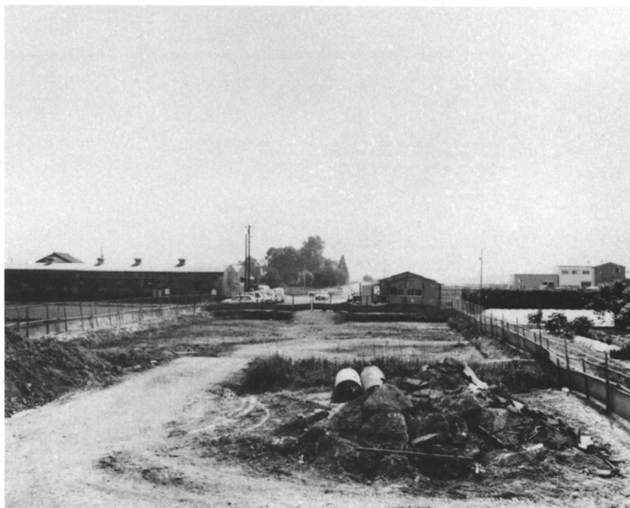
C区 全景 (北東より)
