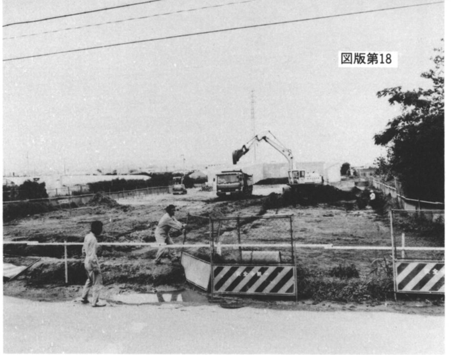
A区 表土掘削 (南より)
