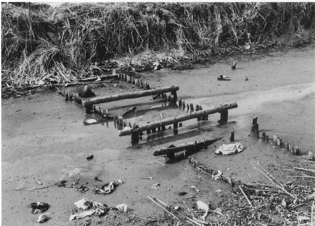
現在のクリーク内に設置された施設の状況
