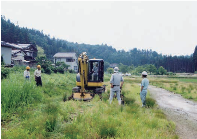
岩清水遺跡 調査風景（西から）
