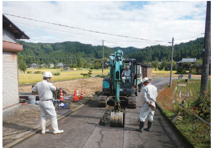
芦ノ出遺跡 調査風景 (南東から)
