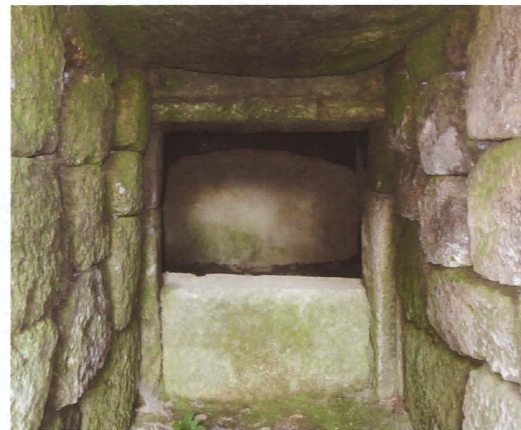
白土が残る堀越古墳の石室
