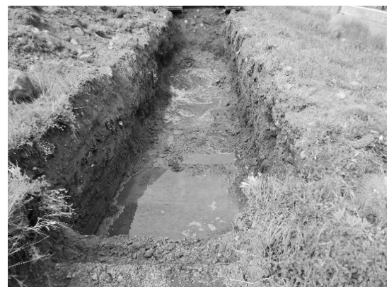
写真1 30次トレンチ状況
