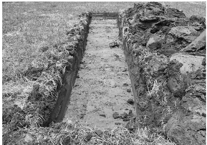
写真14 沖代町二丁目73番6 トレンチ状況
