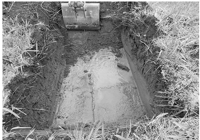
写真19 東浜原口地区トレンチ状況(南から)
