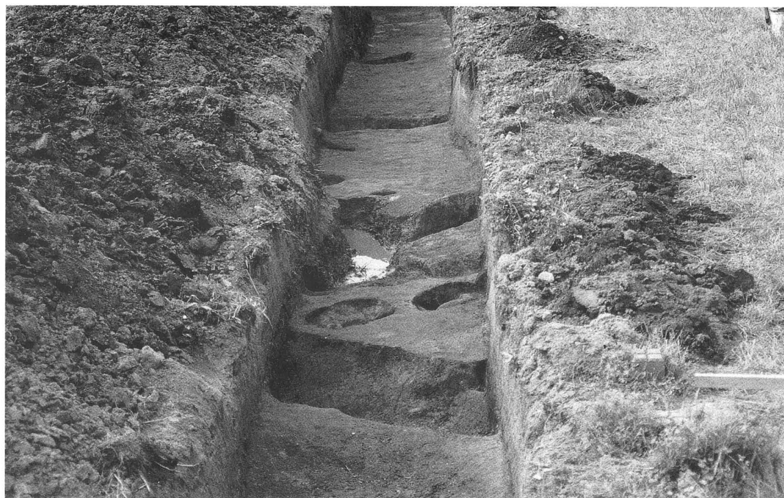
H-1区 全景（南側から）
