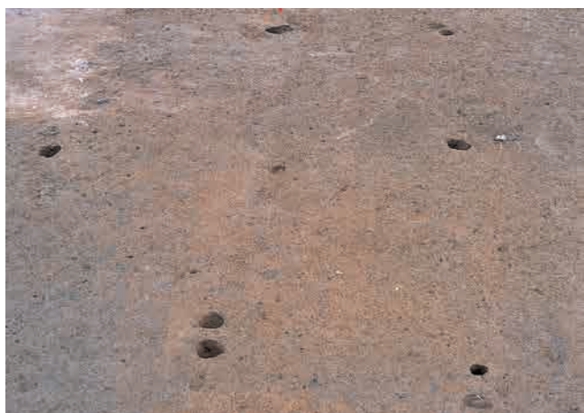
ST04 完掘 (南から)
