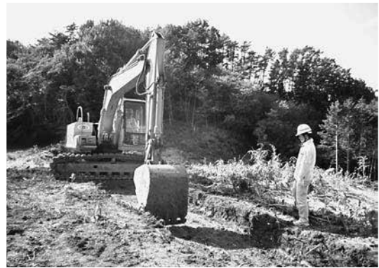
1区トレンチ掘削
