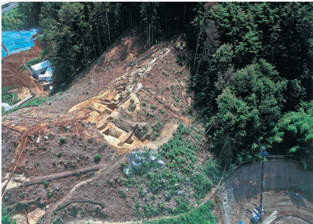
2区SD201 遠景 (北西から)
