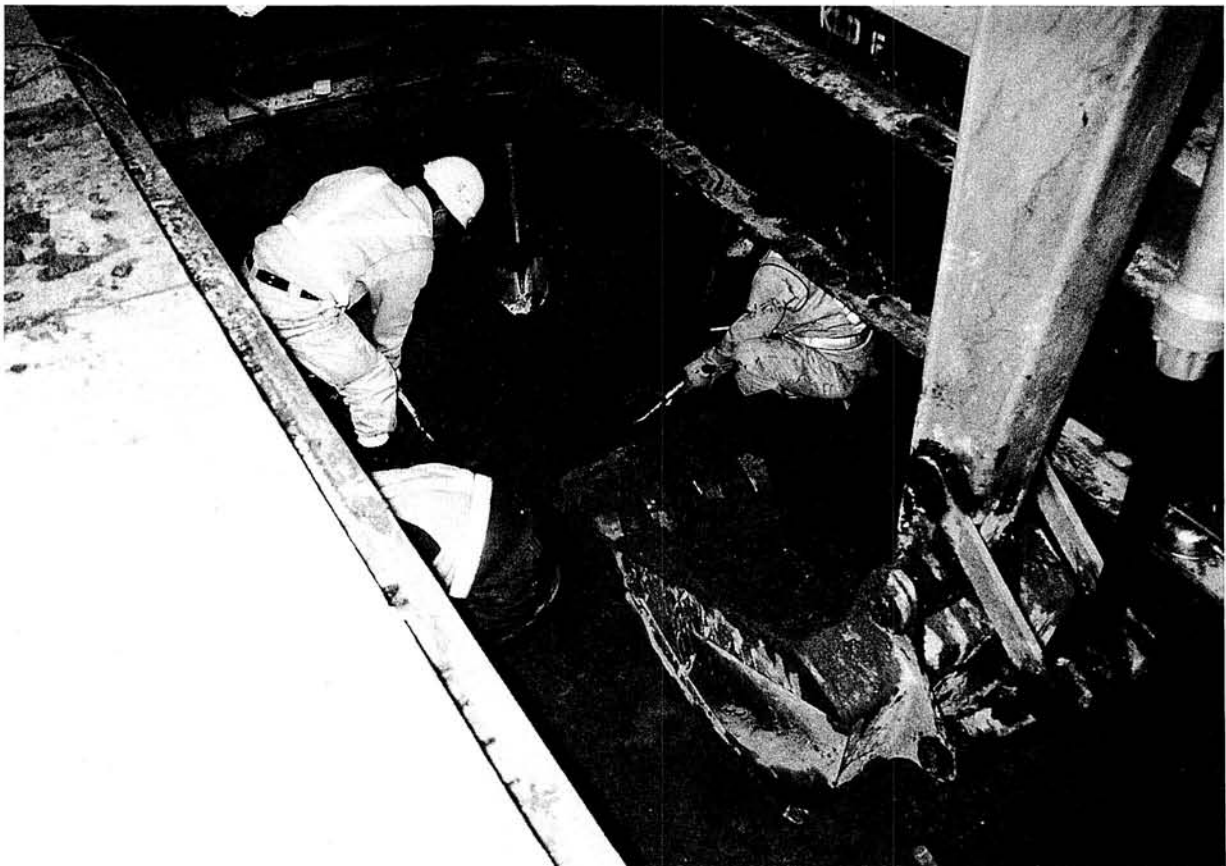
b 調査作業風景 (西から)
