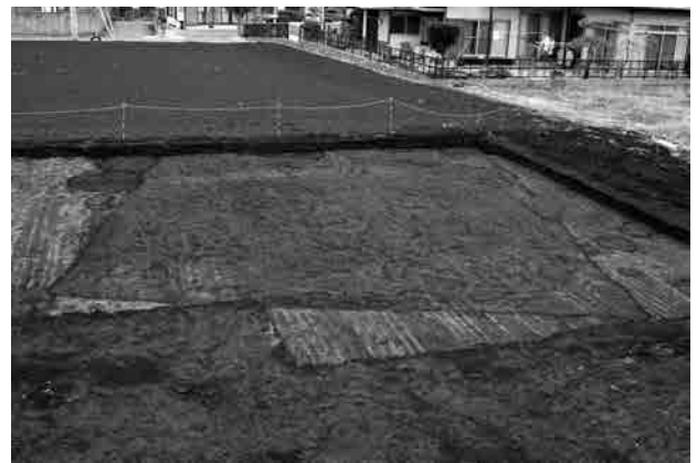
写真1 遺構確認状況
