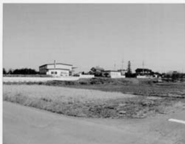
調査地点を南東から望む
