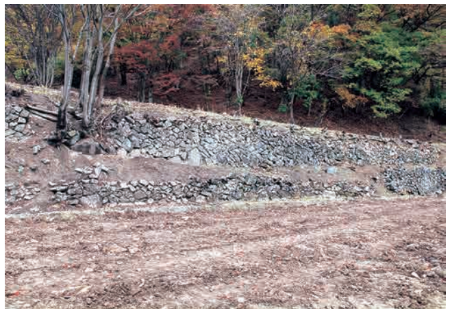
SH40 石垣全景 (西から)
