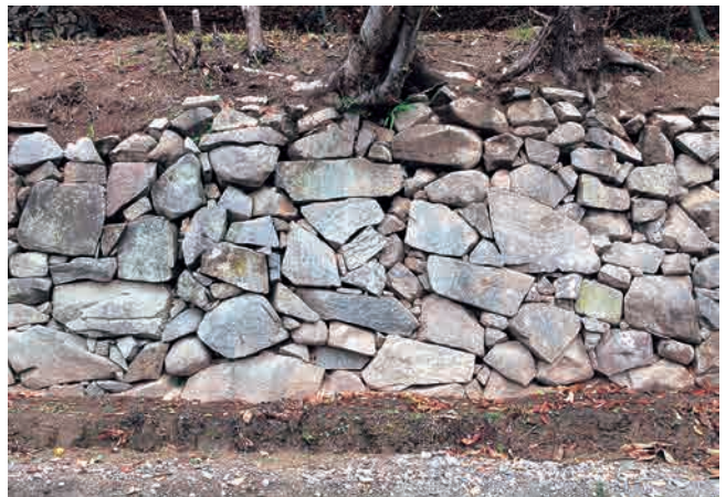
SH39-(2) 石垣 (西から)
