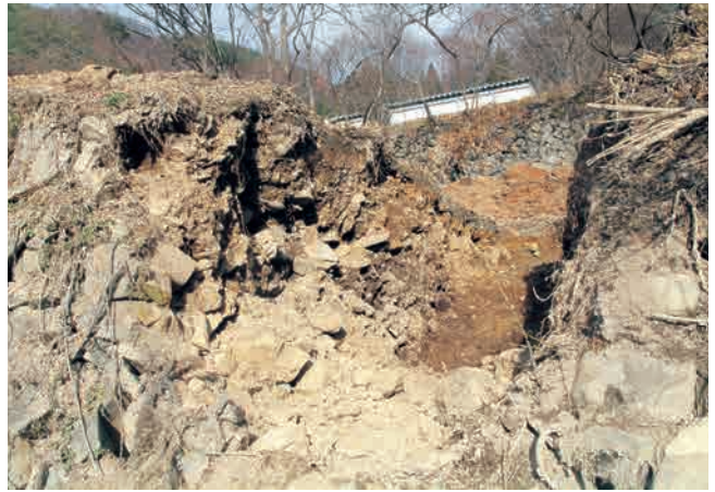
平坦地26 トレンチ断面 (南から)
