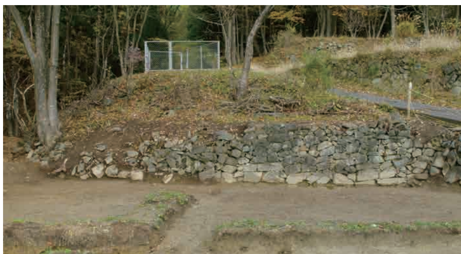
平坦地5 東面石垣検出(西から)
