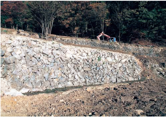
SH41 石垣全景 (西から)
