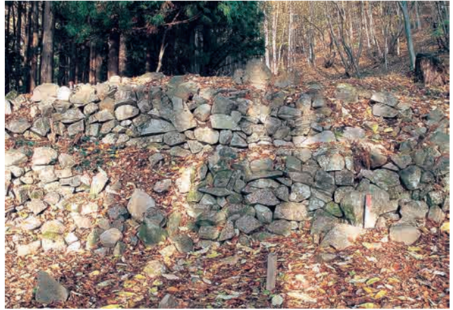
SH36 石垣 (西から)
