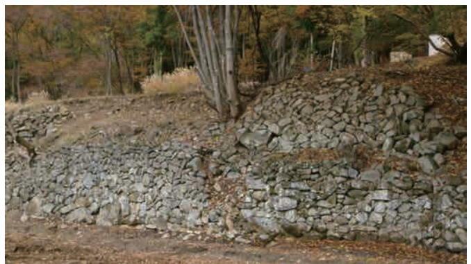
4区 平坦地24東面石垣 SH38(東半部)
