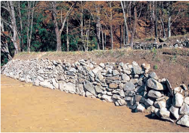
SH04 全景 (西から)
