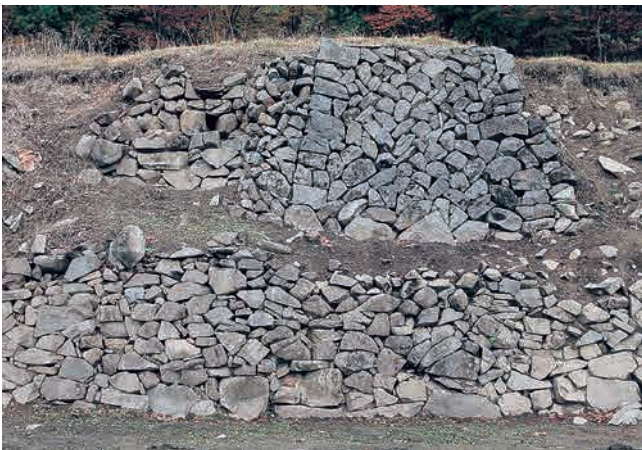
SH38-(1) 石垣 (西から)
