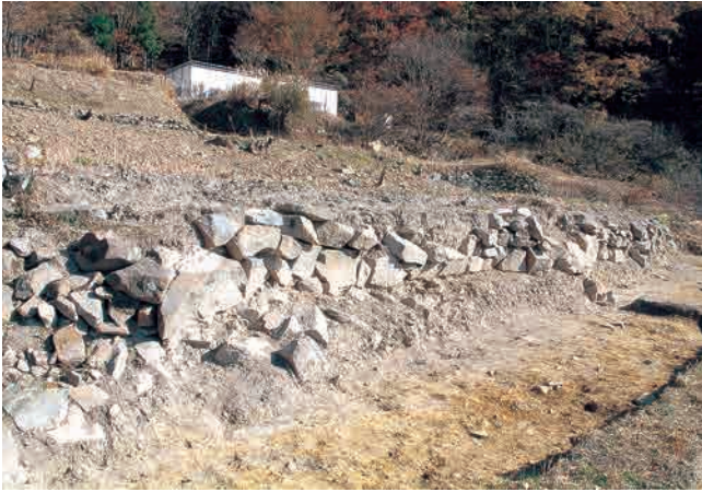
SH08 全景 (西から)
