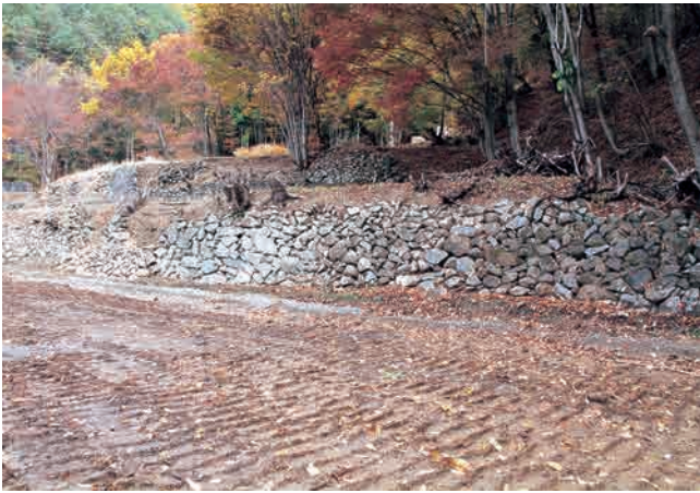
SH39 石垣全景 (南東から)
