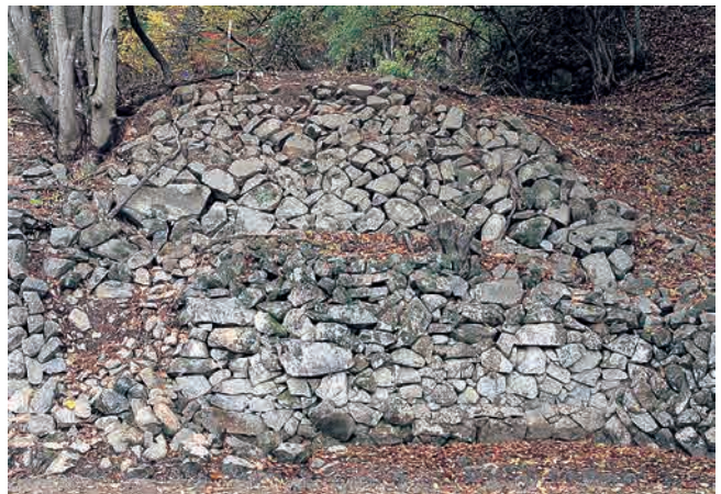
SH38-(2) 石垣 (西から)
