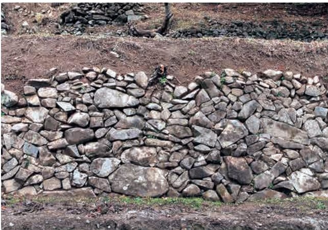
SH39-(1) 石垣 (西から)
