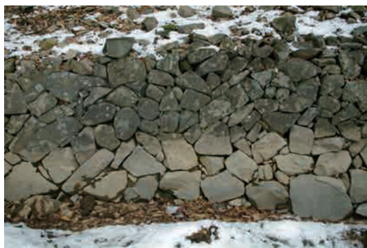
2区 平坦地14 SH10接写(南から)
