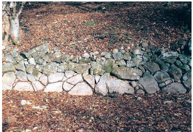
SH37-(1) 石垣 (西から)
