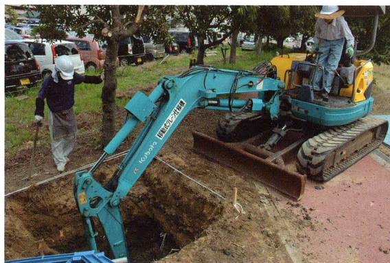
T3 掘削状況
