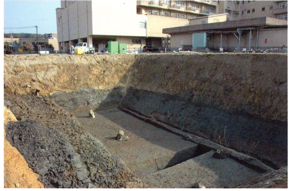
完掘状況から（北西から）
