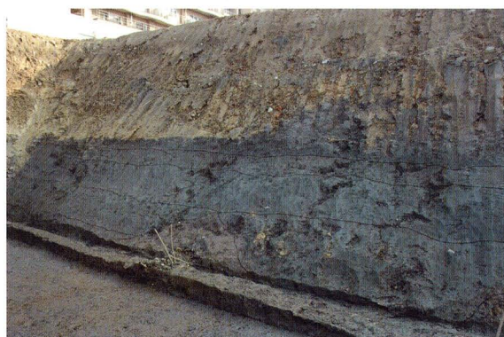
土層堆積状況（南壁）
