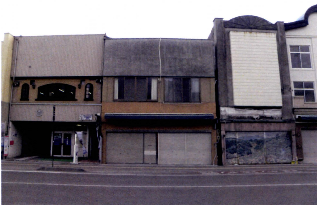
柳口周辺遺跡調査地解体前（東から）
