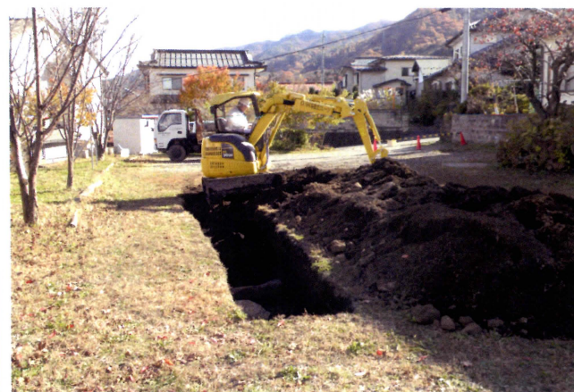
重機による埋め戻しの様子 (北から)
