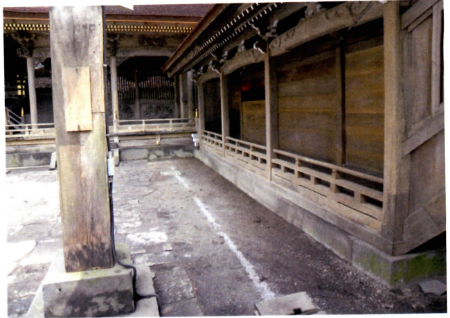
調査前（北西から）
