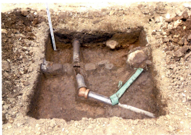
2 グリッド完掘 (南から)
