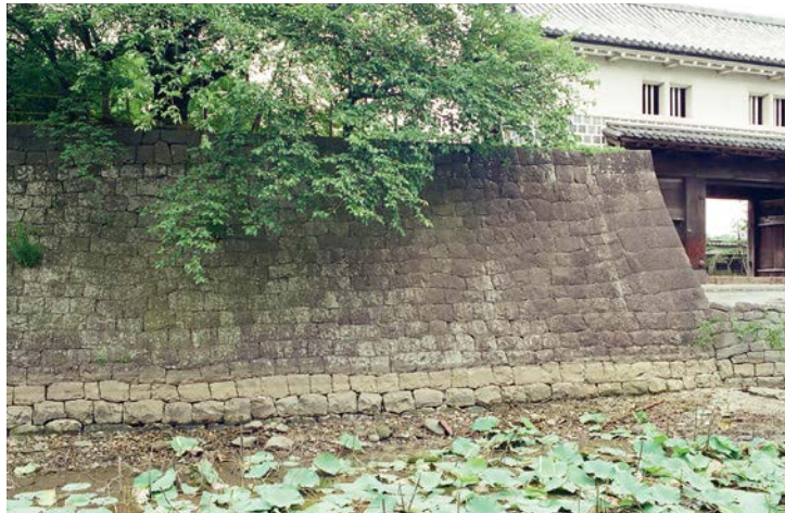
本丸南辺石垣（E面：旧二の丸隅櫓―表門間東端，南から）
