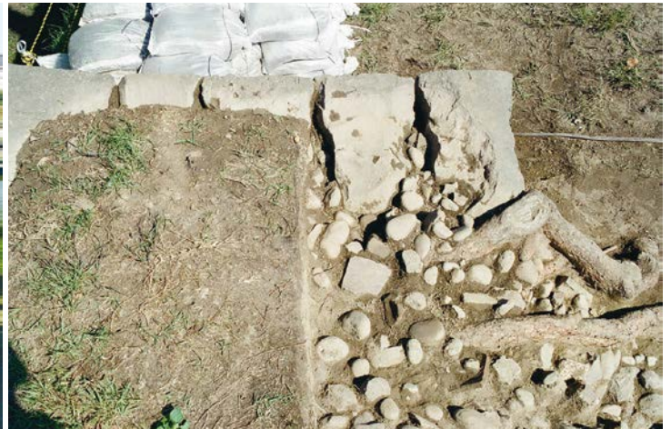
櫓跡東部 つのや跡北東端の石垣裏込め (南西から)
