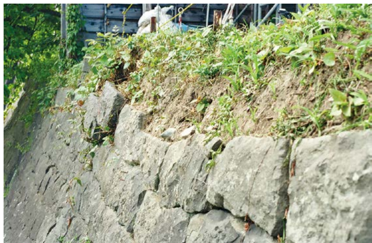
石垣南面 櫓跡南西角石加工状況（南東から）
