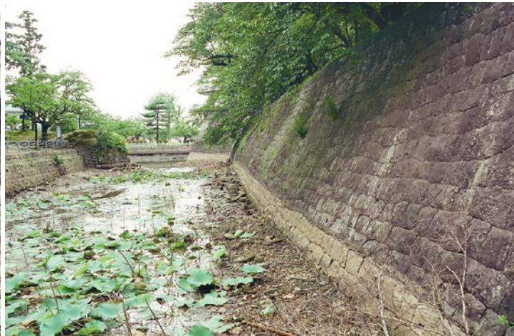
石垣前面堀底 置石検出状況（E面：東から）
