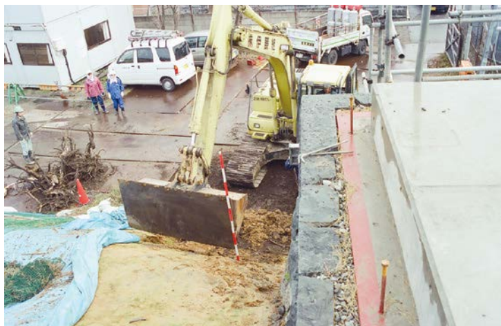
南トレンチ掘削（西から）
