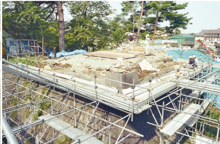
櫓跡上面埋戻し保護状況と石垣南辺・東辺上面検出作業（南東から）
