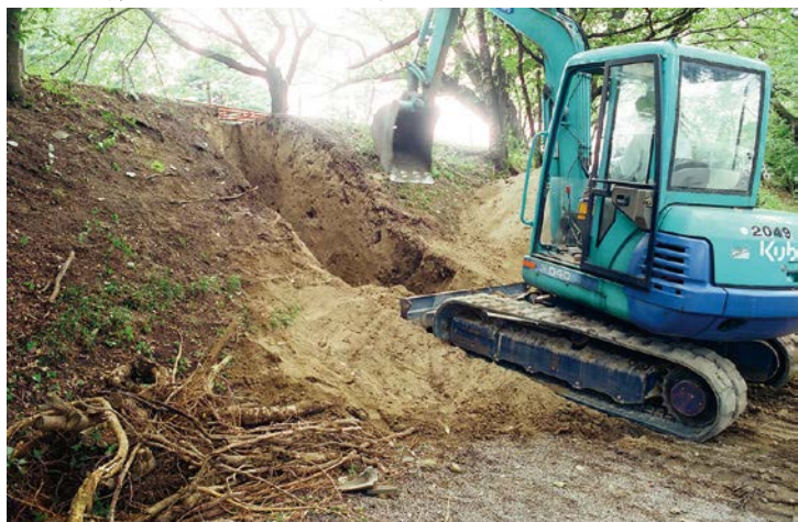
Aトレンチ掘削作業（北東から）
