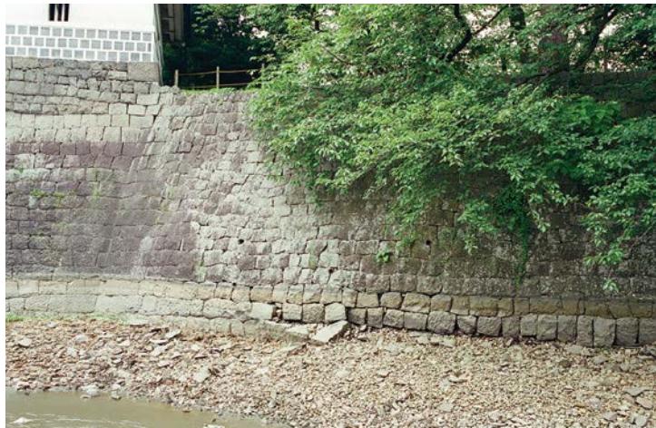
本丸南辺石垣（E・F面：旧二の丸隅櫓―表門間西端，南から）
