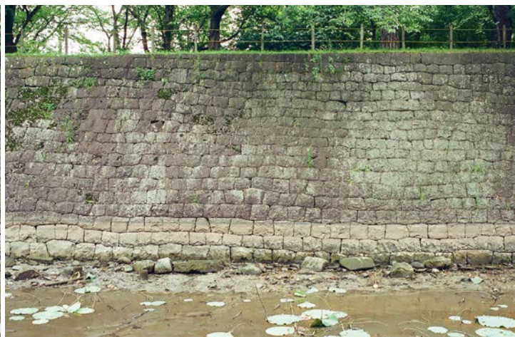
本丸南辺石垣（E面：旧二の丸隅櫓―表門間中央西寄り，南から）
