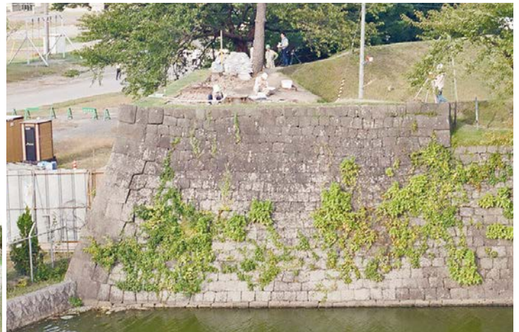
調査前の櫓跡遠景（南西から）
