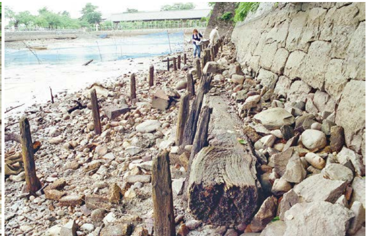
南側折南西面 石垣補強②横木・杭拡大 (I面：南東から)
