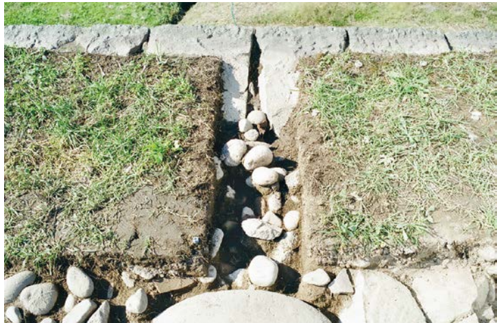
櫓跡西角 石垣天端裏込め (北東から)
