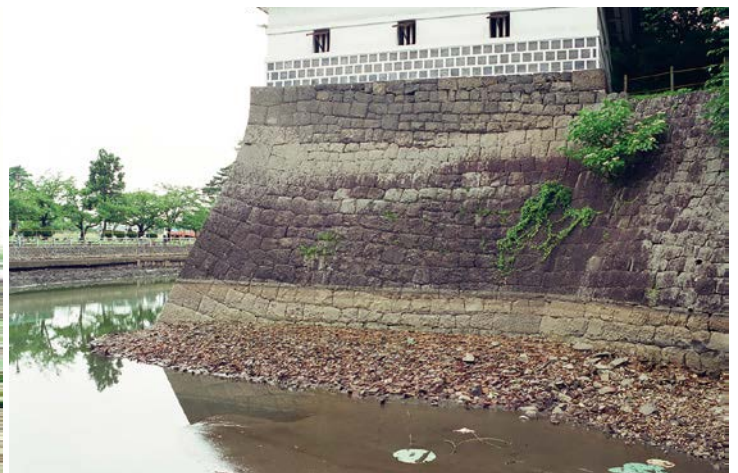
本丸南辺石垣（F面：旧二の丸隅櫓、南から）
