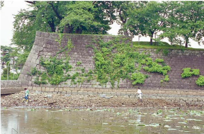
三階櫓南西面下 石垣変形③ (K面：南西から)
