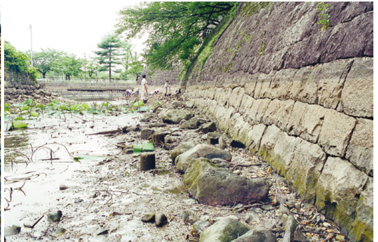
Dトレンチ置石・石垣補強①杭 検出状況 (E面：東から)
