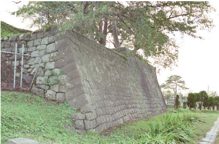
櫓跡北東側 石垣北東面（L・M面：北東から）
