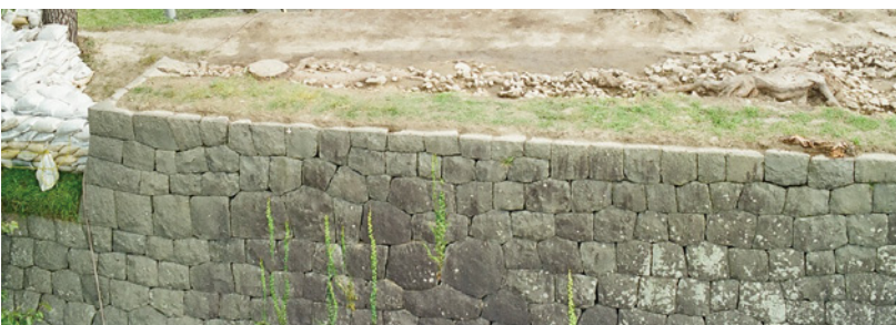
櫓跡東部 つのや跡の基礎上面 完掘状況 (北西から)
