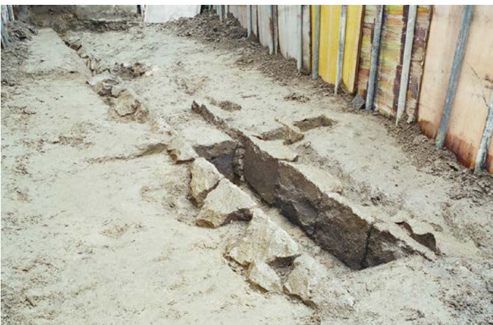
石組み溝内の掘削状況（南から）
