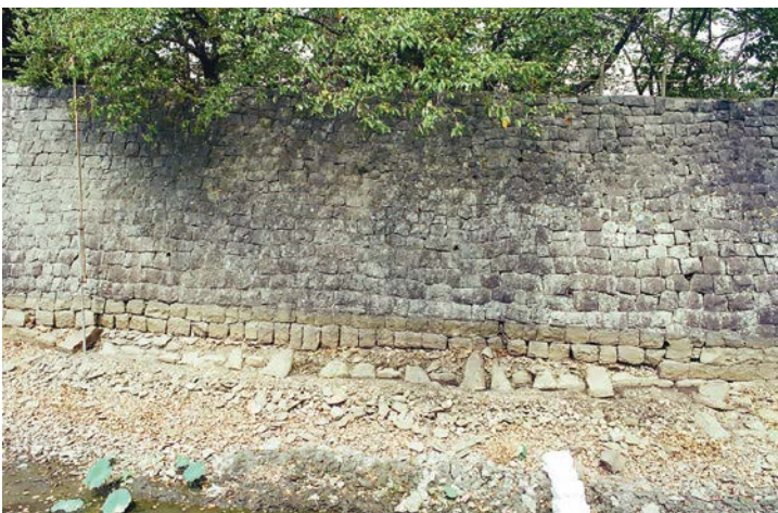
石垣下端の変形と上部積み直し状況 (E面：西側)
