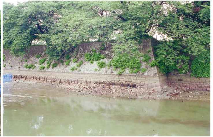
南側折南西面 石垣補強②・③ (I面：南西から)
