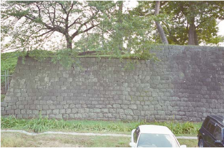
櫓跡北東側 石垣北西面（L面：北西から）
