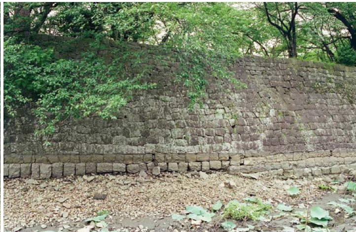
本丸南辺石垣（E面：旧二の丸隅櫓―表門間中央西寄り，南から）
