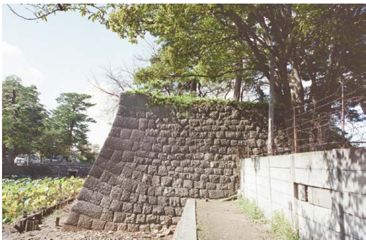
調査前の櫓石垣東面（A面：東から）
