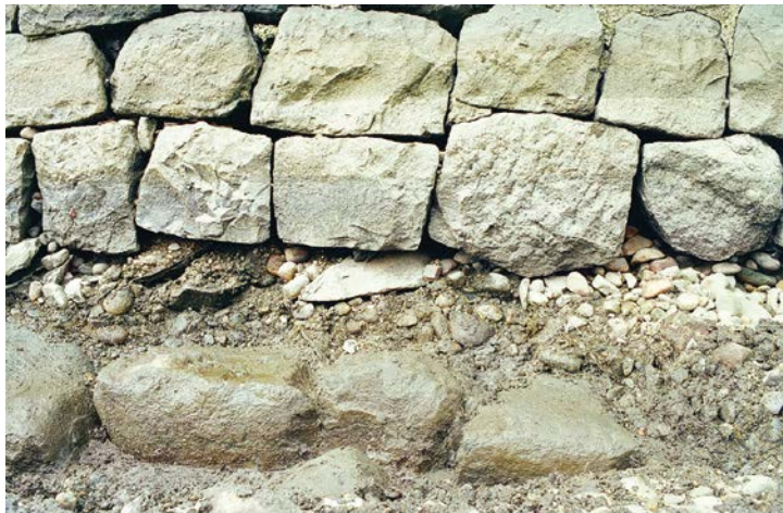
変形石垣と砂利による積み直し部 (E面：拡大, 南から)
