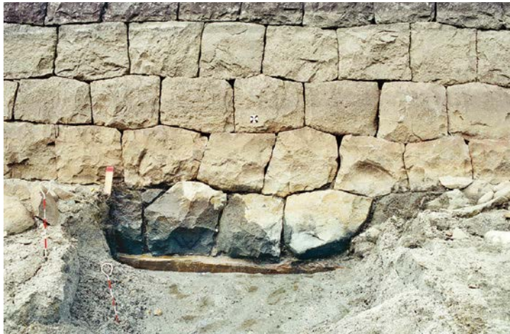
石垣根石・胴木検出状況 (E面：南から)
