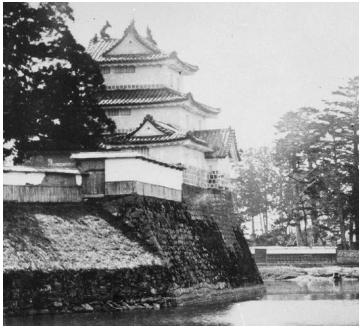
三階櫓 古写真（明治初期撮影，北東から）
