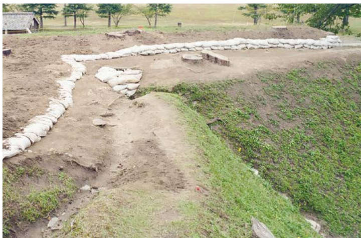
櫓跡上面 埋戻し保護完了（南東から）
