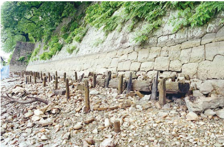
南側折南西面 石垣補強②・③横木・杭打ち留め (I面：南から)
