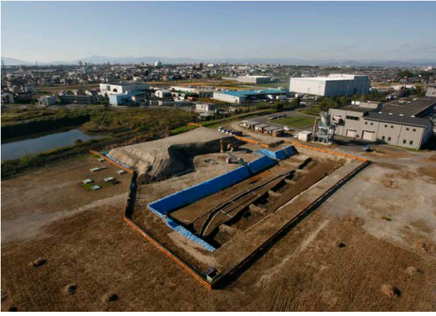
10区 1面遠景 (南東より)
