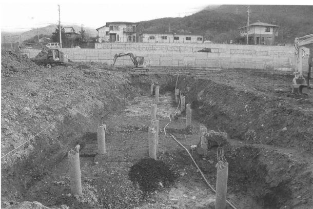
18号トレンチ (西より)
