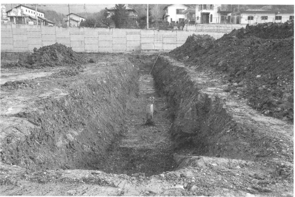
19号トレンチ (西より)
