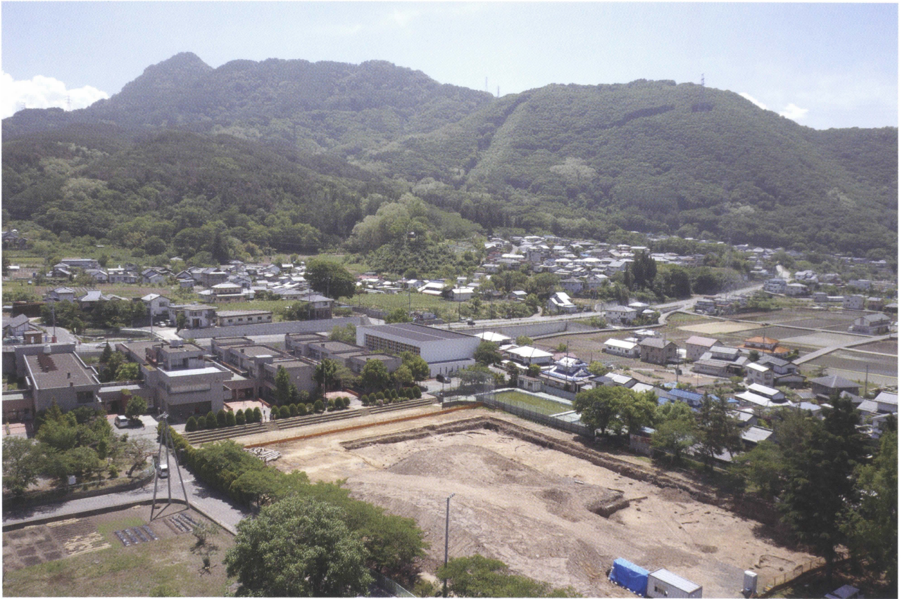
大木久保遺跡Ⅱ（北西より）
