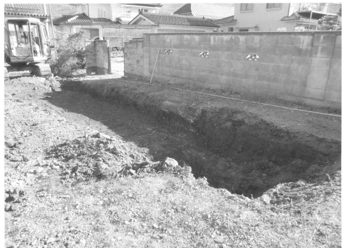
トレンチ検出状況 (西より)
