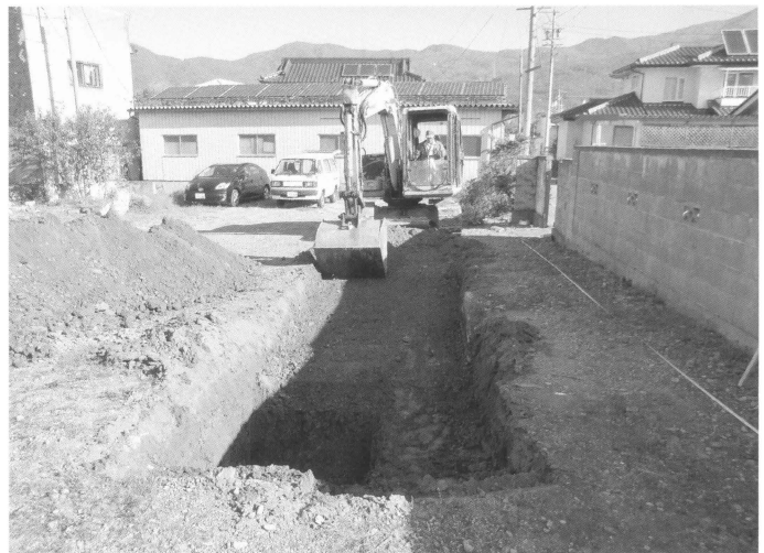
トレンチ掘削状況 (南西より)
