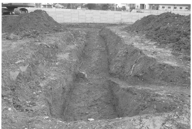
20号トレンチ検出状況（西より）
