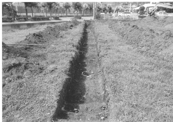
2号トレンチ検出状況 (南東より)
