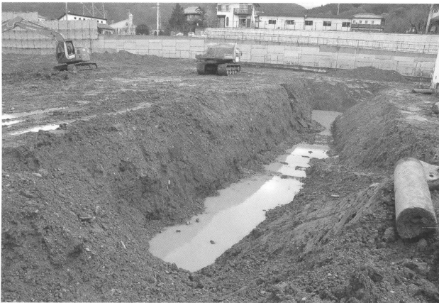
17号トレンチ検出状況（西より）
