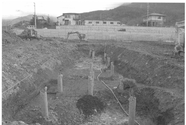
18号トレンチ検出状況（西より）
