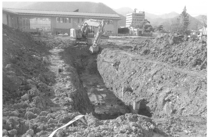
トレンチ掘削状況 (東より)
