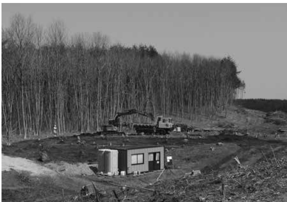
重機稼働風景
