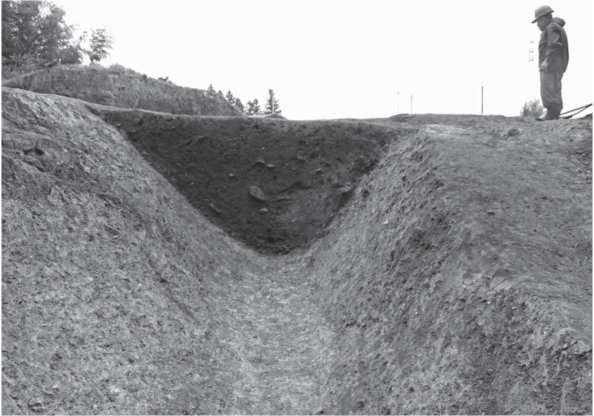
1号堀跡断面（西から）
