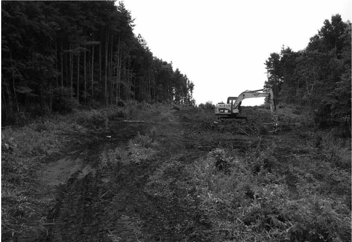
南側調査区 調査前風景①
