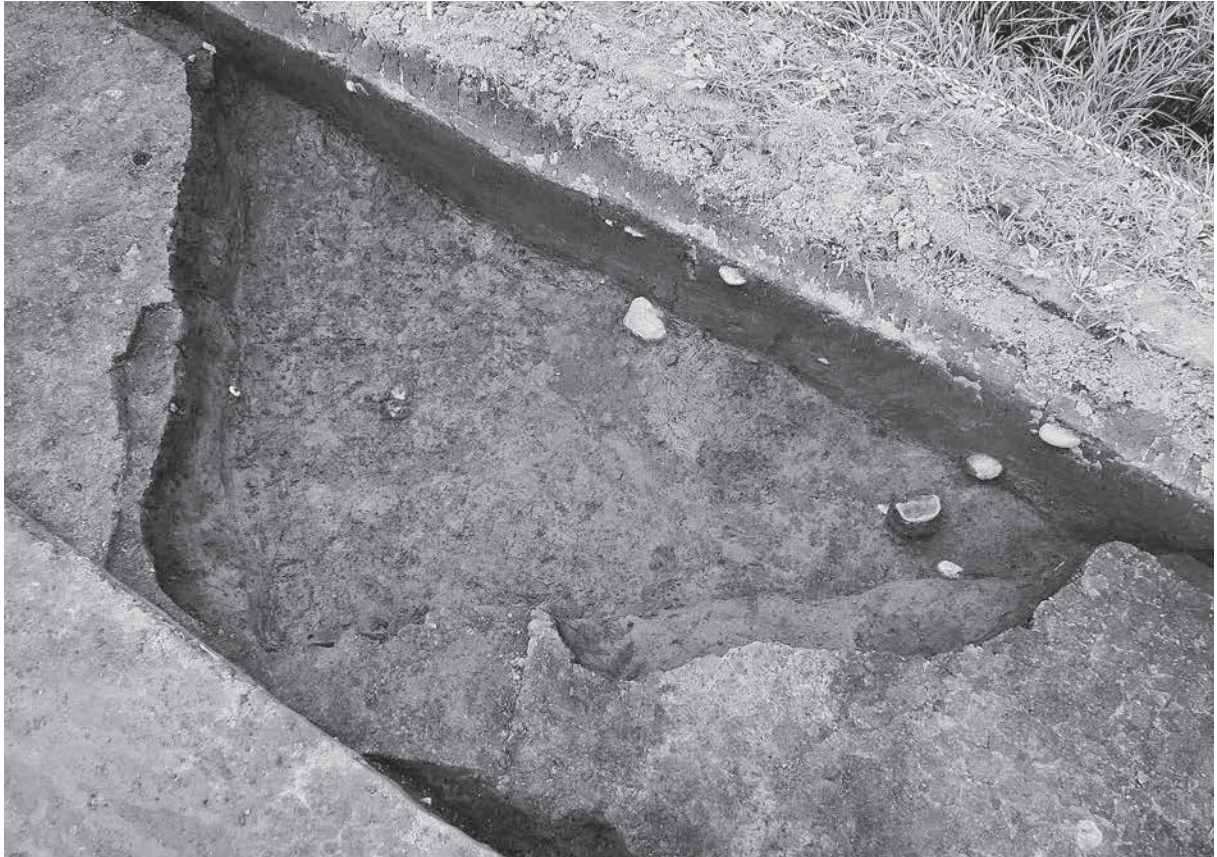
近景(南東から)
