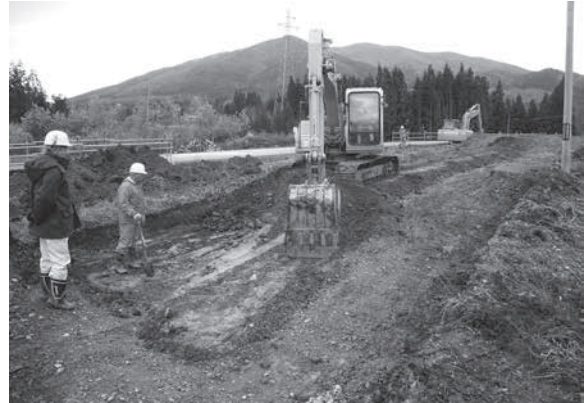
碎石盛土除去作業（北から）
