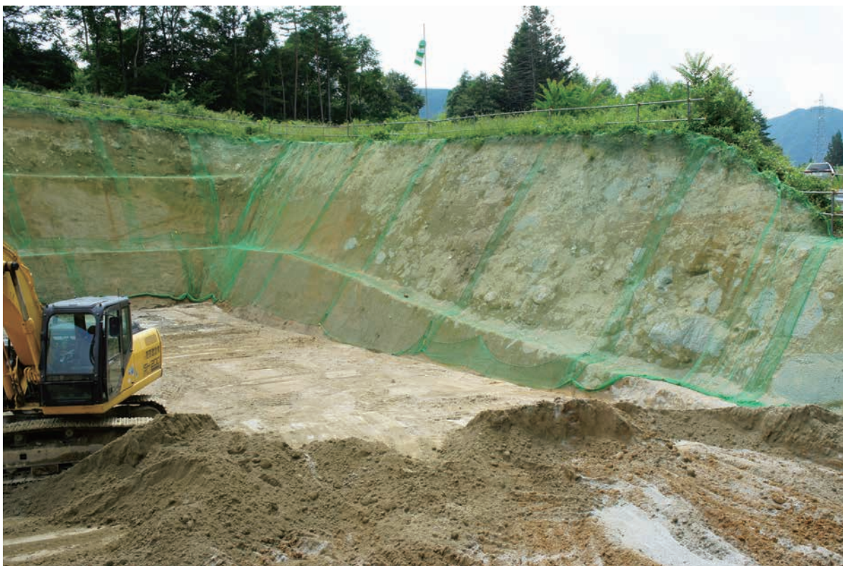
【図4-2】 高位緩斜面堆積物を切る斜面（高位緩斜面/L2面間の段丘崖）を覆う、低位緩斜面堆積物の露頭。写真右の露頭面に現れた花崗岩礫は芯まで風化しておらず、礫の切断面が凸凹している。
