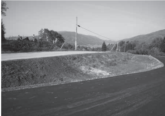
着手前の現道（南東から）
