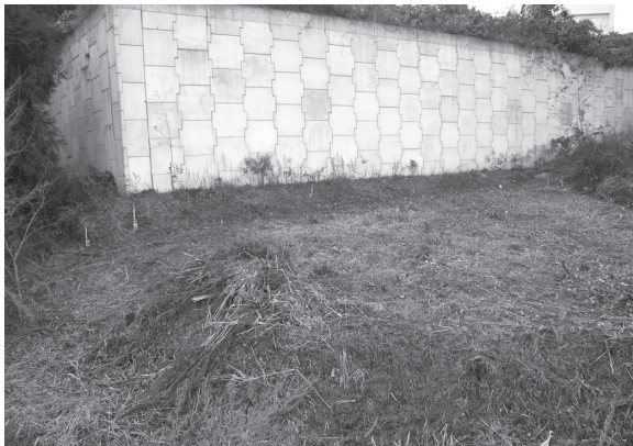
北側調査区調査前（東から）
