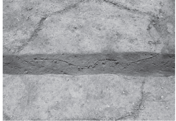
RF39 断面 (南から)
