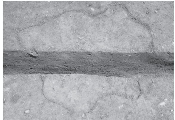
RF41 断面 (南から)
