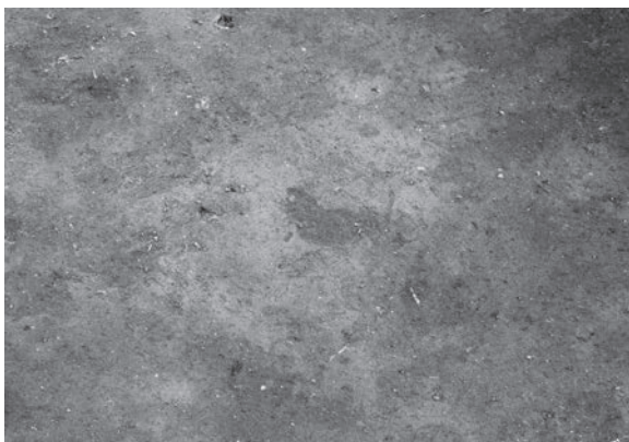
RF38 全景 (南西から)
