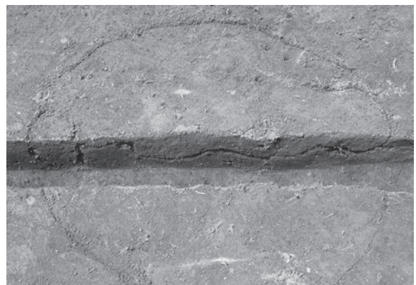
RF22 断面 (東から)
