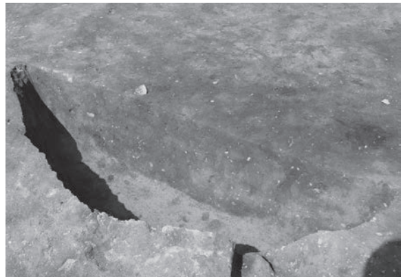
RD55 断面 (東から)
