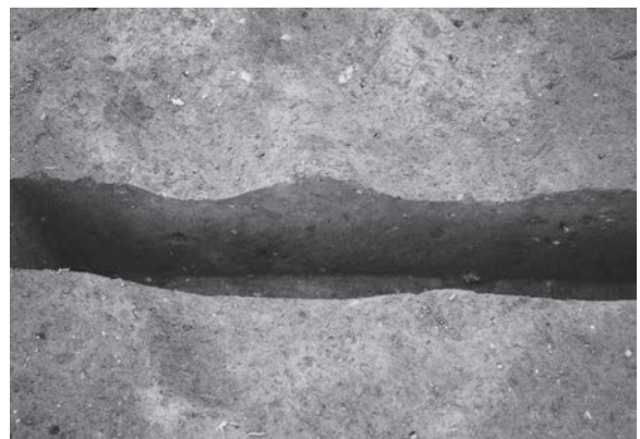
RF42 断面 (東から)
