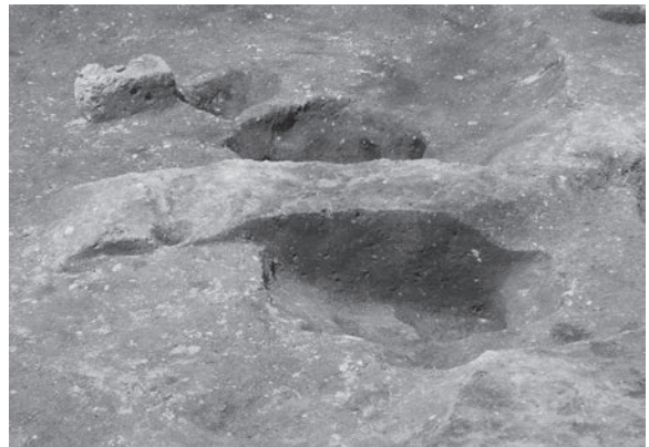
RA55 東壁側断面 (南から)
