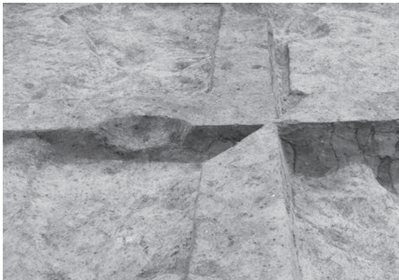
RA27断面近景(西から)
