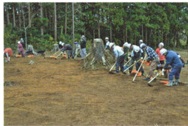
「表土除去作業」
