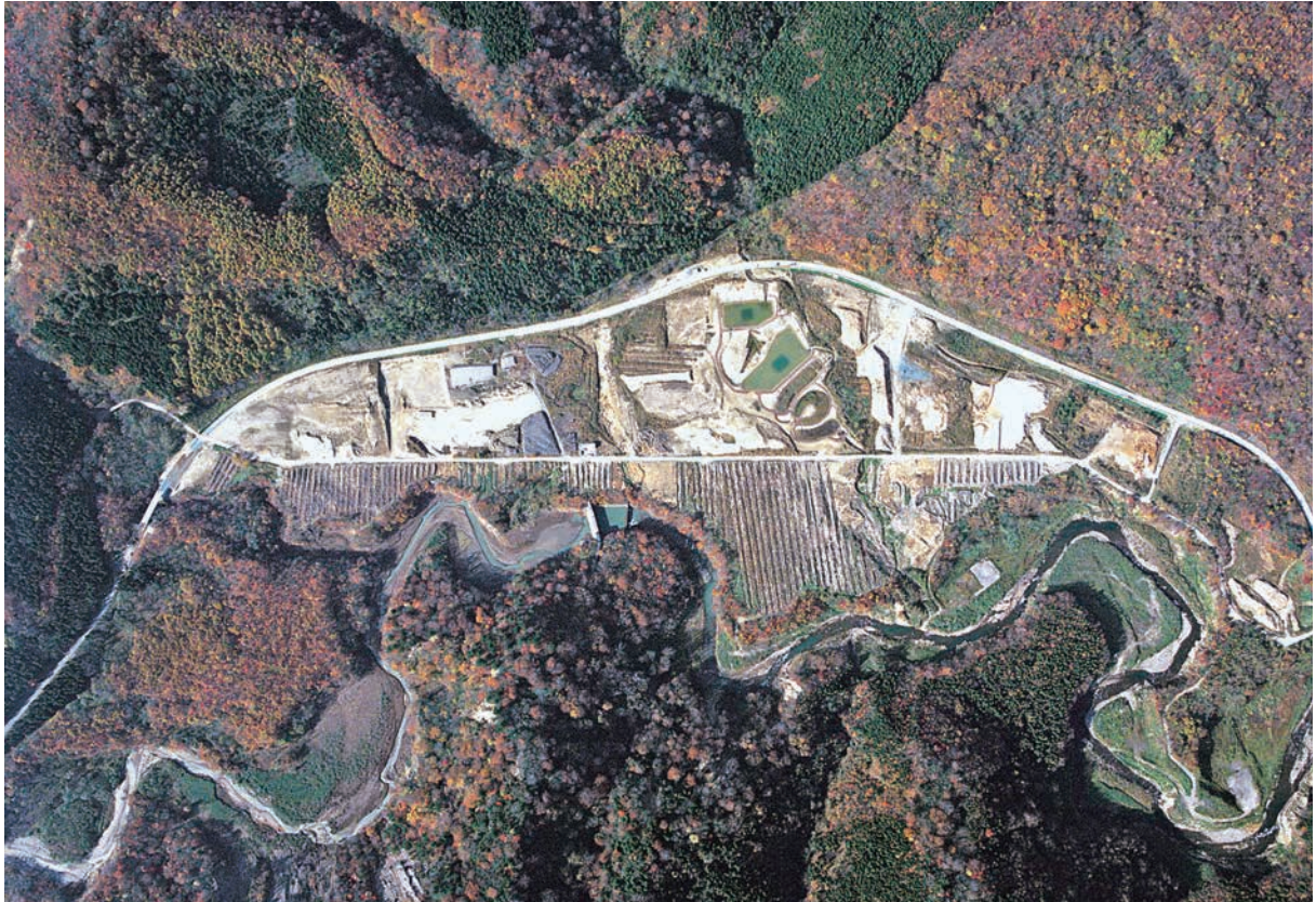
大平野Ⅱ遺跡調査区全景(南東から)
