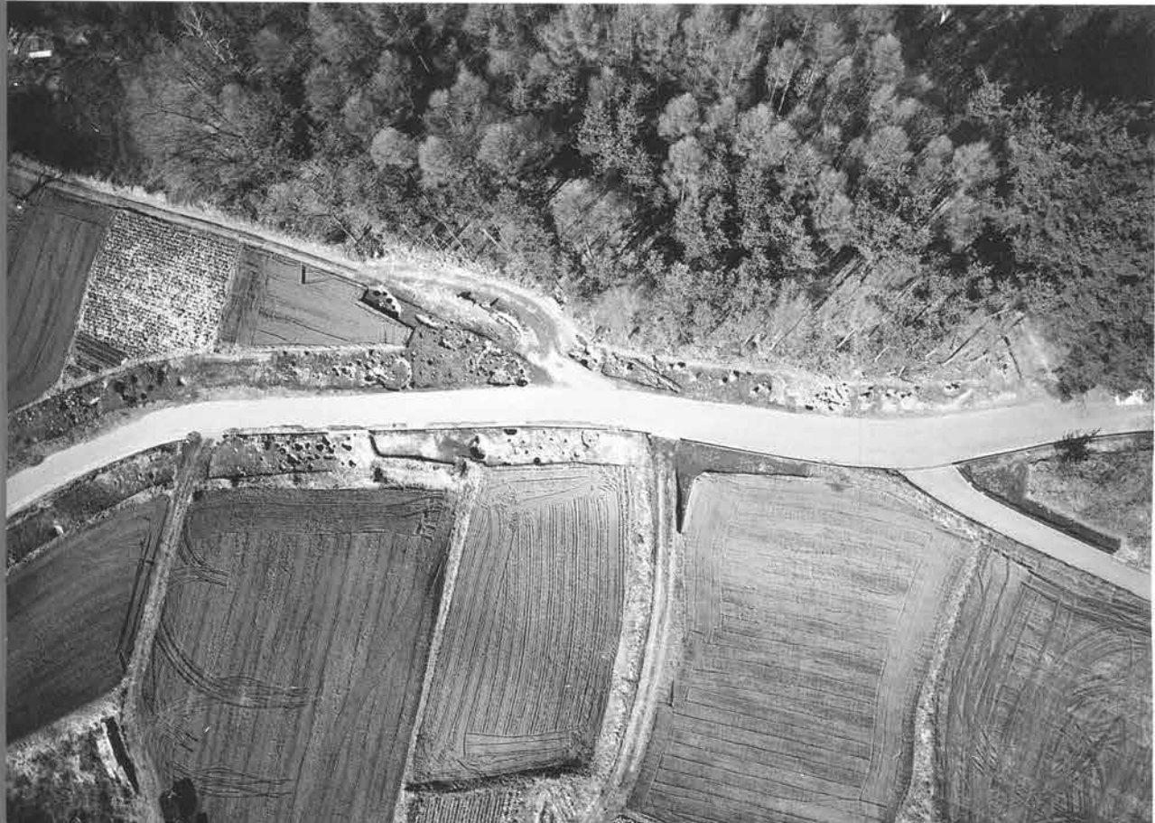
市道拡幅部分全景
