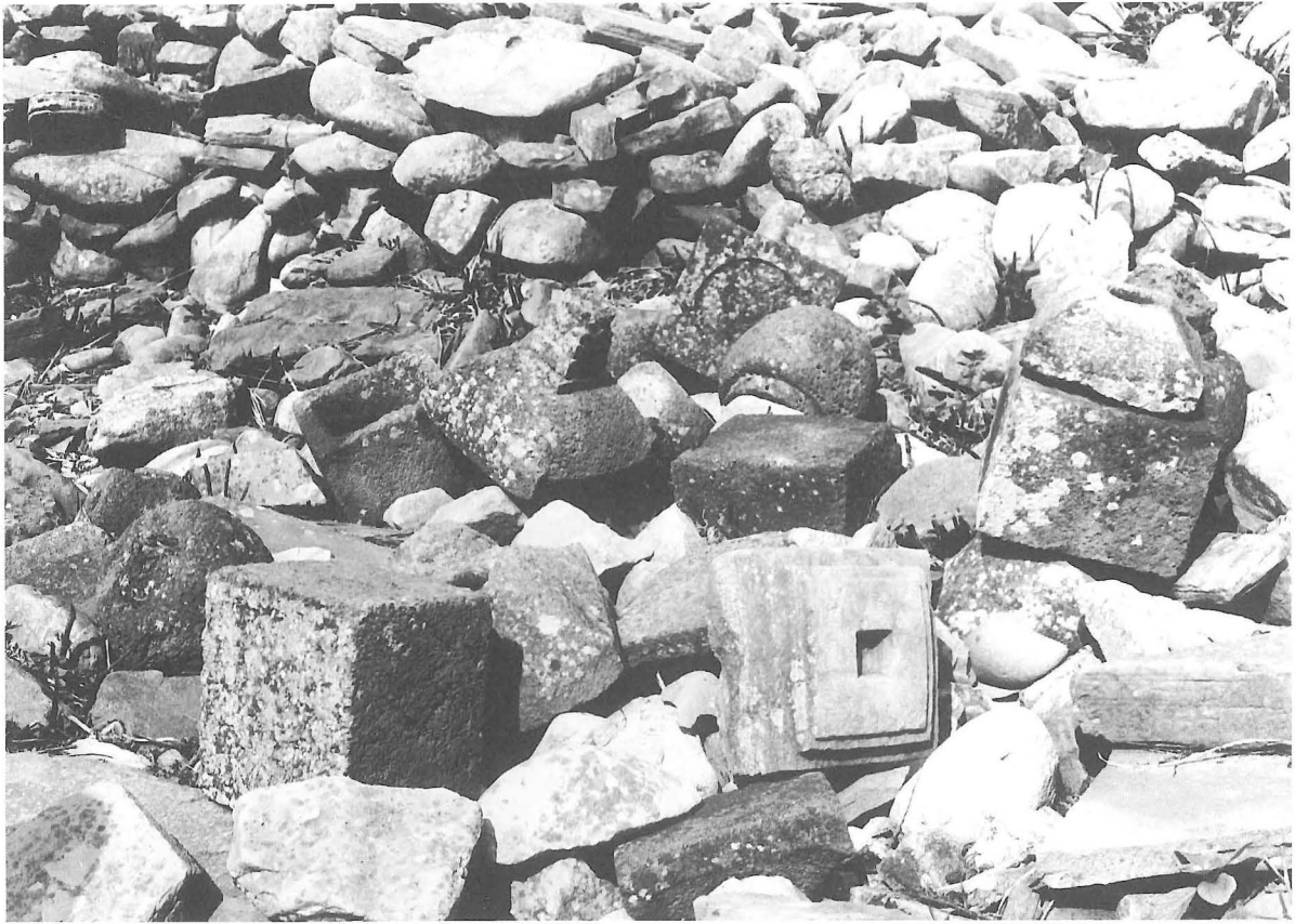
崩壊した石塔群
