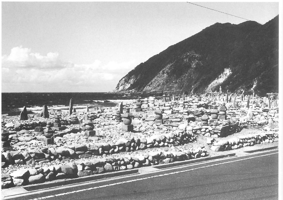
町道北側の整備後の状況
