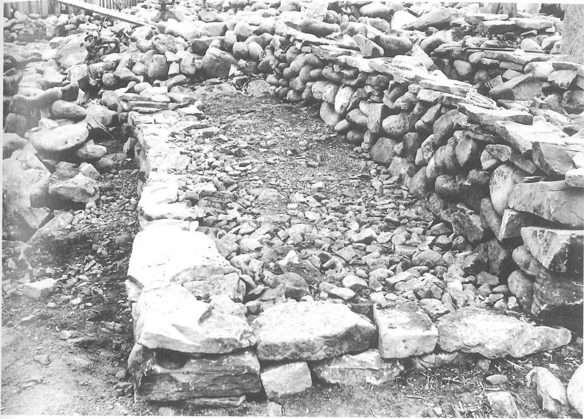
石垣部分の復原状況
