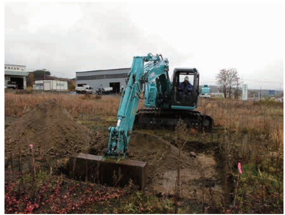
写真52 掘削状況(S→)
