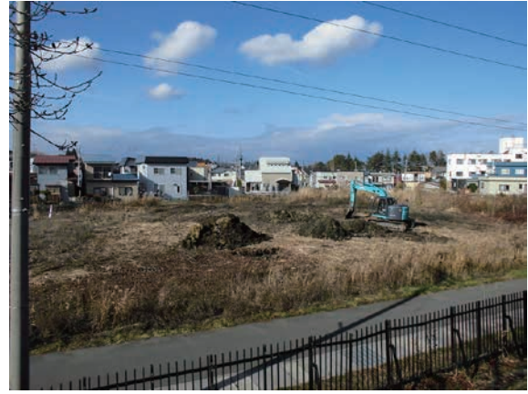
写真60 掘削状況(E→)
