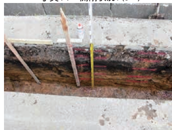
写真16 開削状況3(W→)
