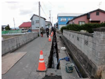
写真14 開削状況1(S→)
