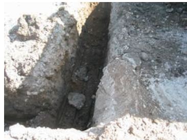
写真40 掘削状況(W→)
