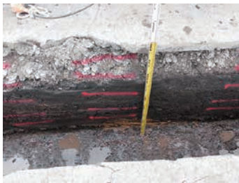
写真15 開削状況2(W→)
