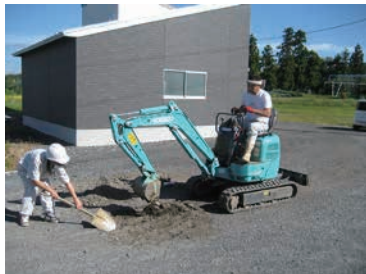
写真39 掘削状況(S→)
