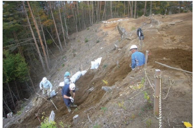
法面掘削作業
