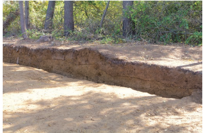
南壁断面（北西より）
