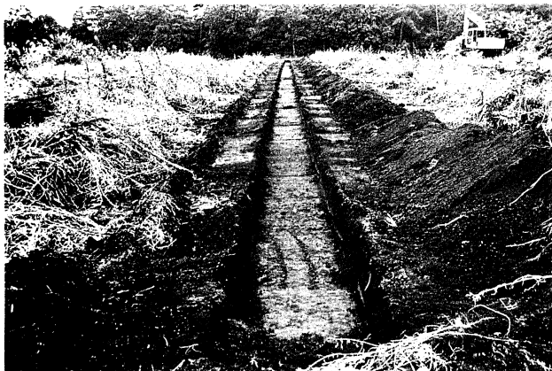
1. 小暮北新地遺跡 トレンチ掘削状況
