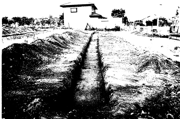
1. 小暮十二林 トレンチ掘削状況
