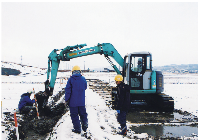
鬼倉遺跡 17 トレンチ調査風景（南西から）
