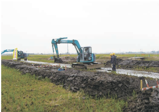
丸瀉遺跡 調査風景 (北から)
