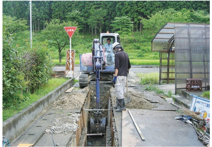
舞台遺跡 調査風景 (南から)
