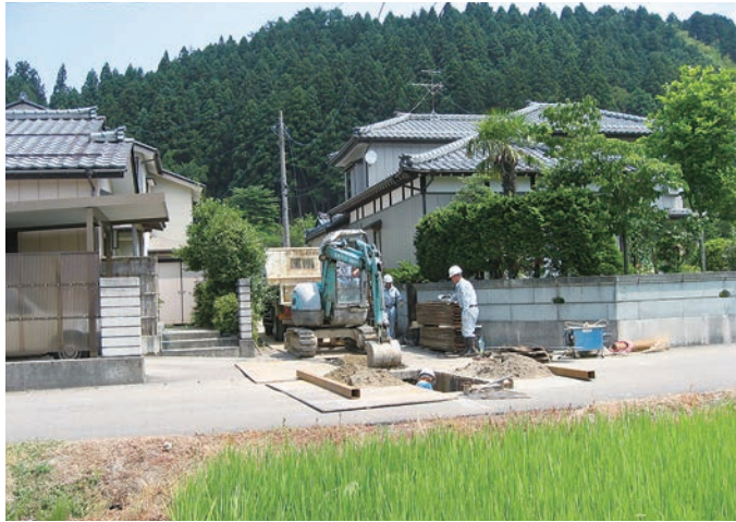
舞台遺跡 調査風景 (南から)
