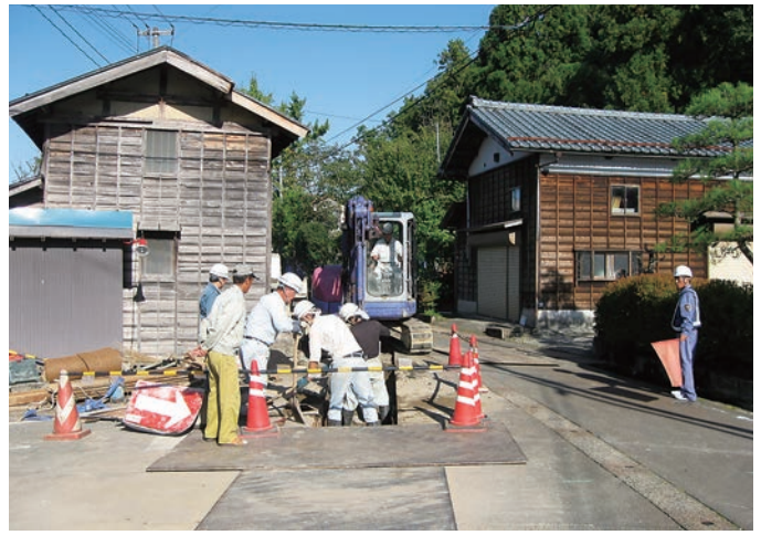
花立遺跡 調査風景 (西から)
