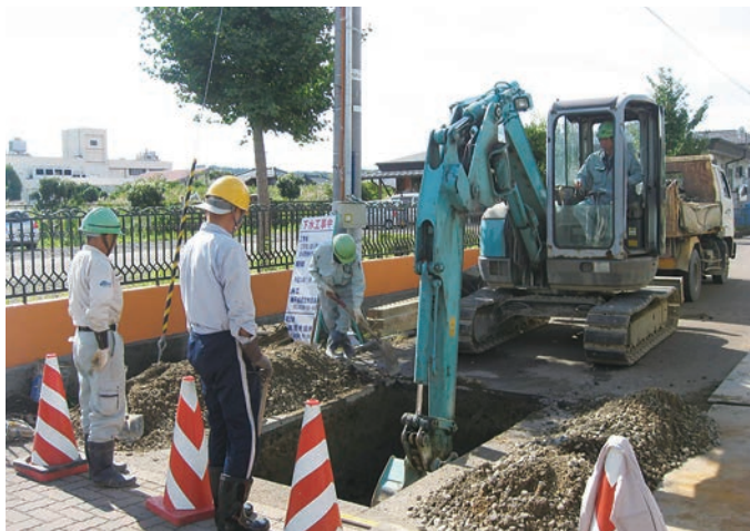
釜淵遺跡 調査風景 (北から)
