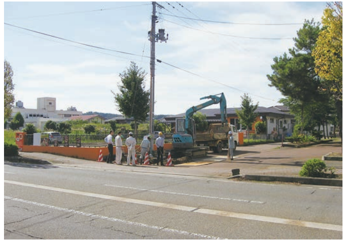
釜淵遺跡 調査風景 (北から)
